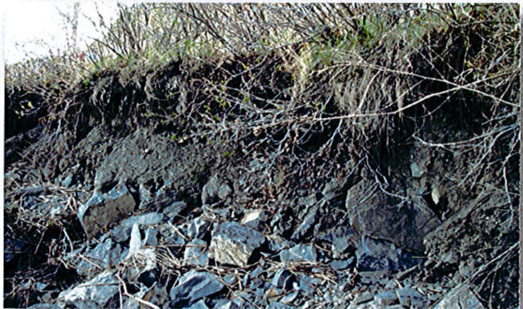
Figure 7 Érosion de la partie supérieure des pentes (secteur EB07-EB10)
