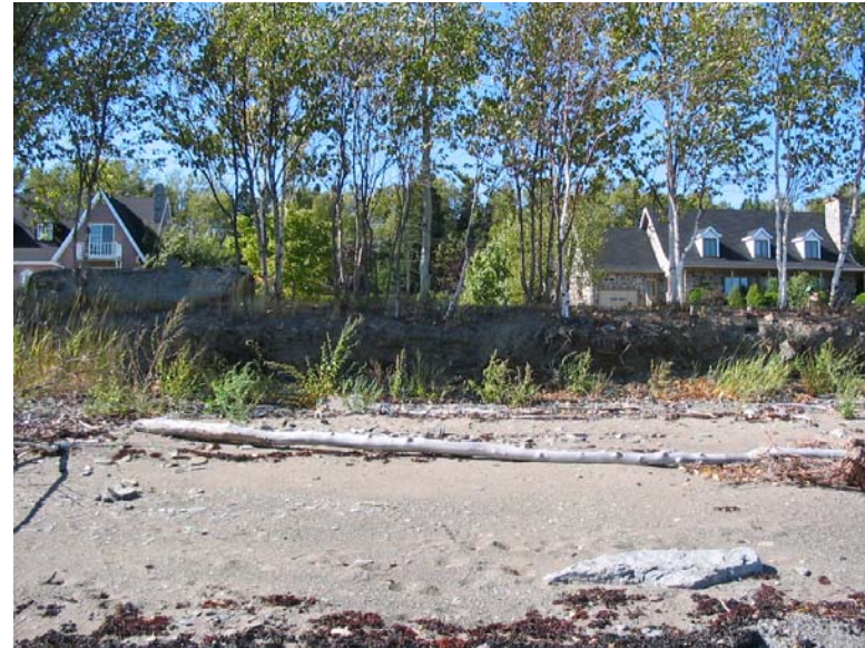
Photo 14 : Talus érodé aux environs du chaînage 11+050 avec arbres en porte-à-faux.
