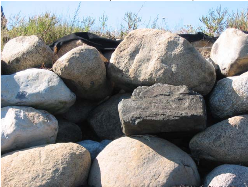
Photo 8 : Ouvrage de protection en pierres sub-arrondies de calibre 1000-800 mm (enrochement « 4 »).
