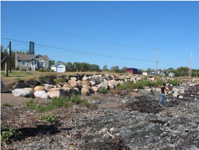
Photo 8 : Ouvrage de protection en pierres sub-arrondies de calibre 1000-800 mm (enrochement « 4 »).
