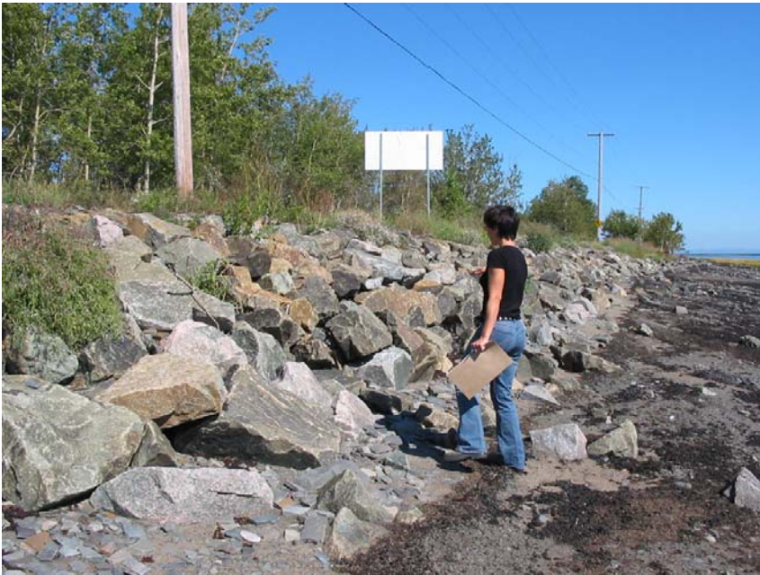
Photo 4 : Ouvrage en enrochement « 2 » constitué de pierres de calibre 800-700 mm (550 à 750 kg).
