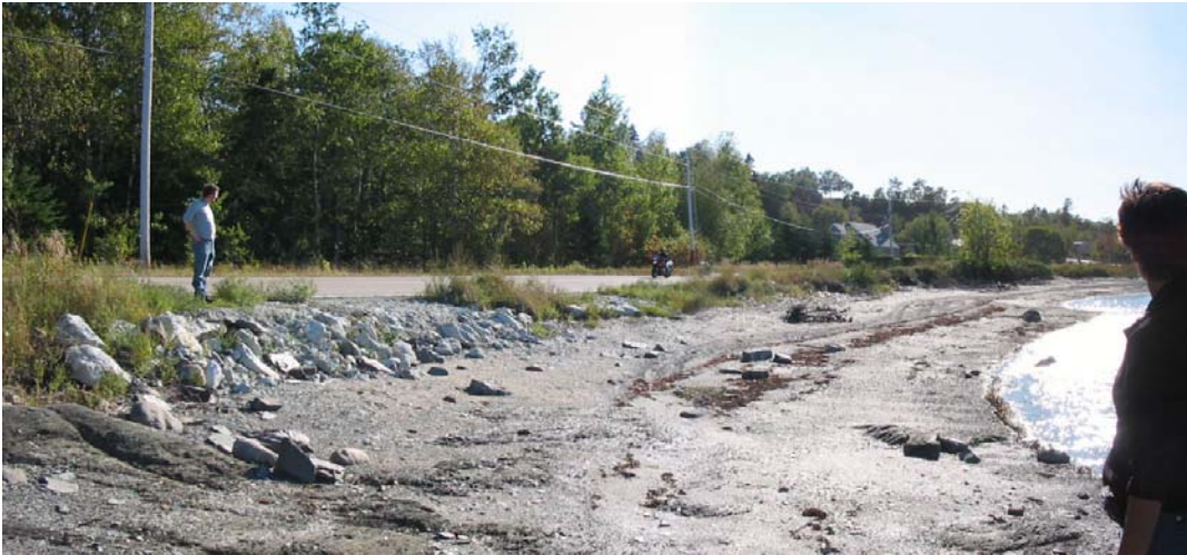
Photo 1 : Site 1, côté nord-est, secteur à protéger.
