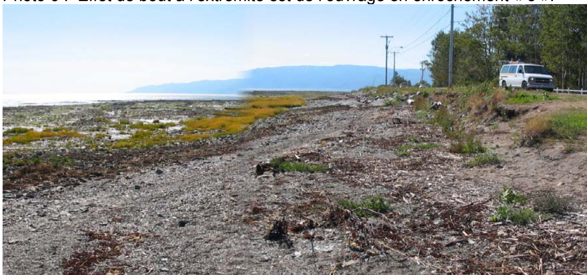
Photo 7 : Zone non protégée entre l'ouvrage en enrochement « 3 » et la pointe où est située le belvédère.
