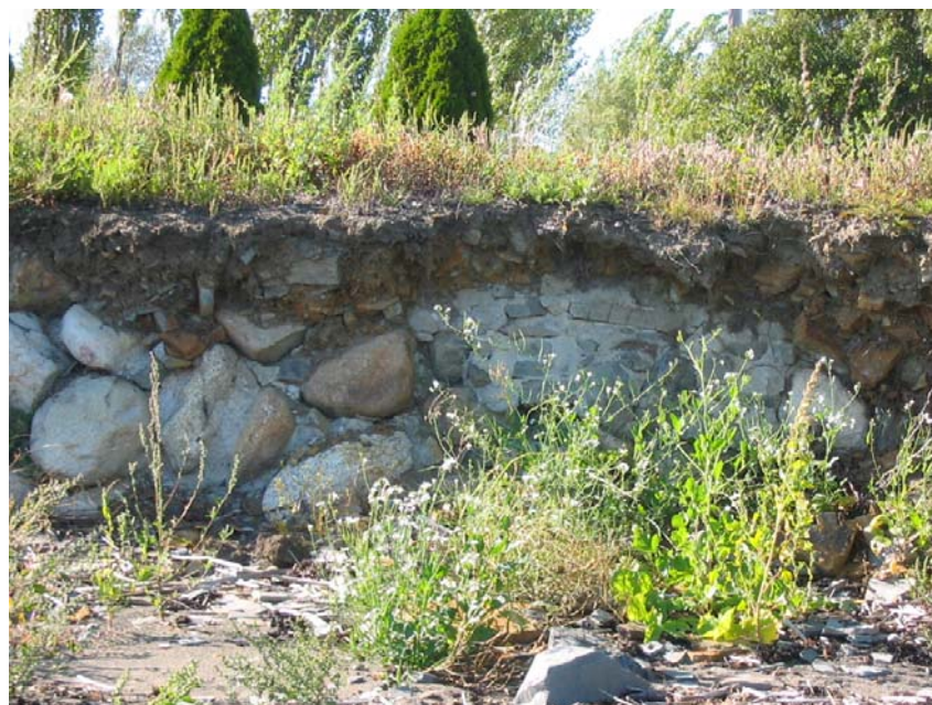
Photo 22 : Anciens quais ou murets en pierres cimentées et en briques au niveau du remblai de la chaussée observés par endroit entre les chaînages approximatifs 12+030 et 12+200.
