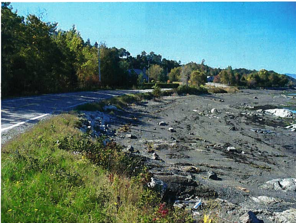
Figure 10 : Photo du secteur nord-est à empierrier, qui fait l'objet d'un CA pour l'automne 2007
