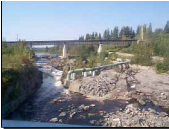
Figure 2.11 Émissaire de l'usine Abitibi-Consolidated dans le Petit Bras
