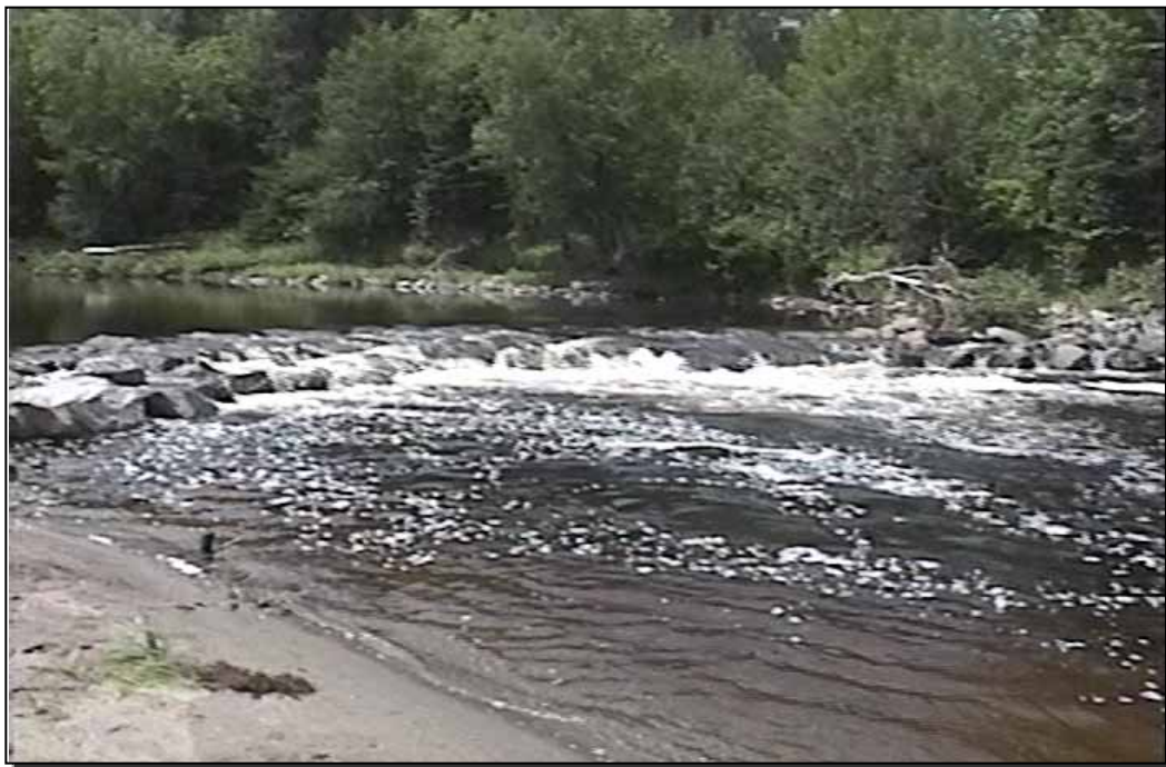
Figure 3.6 : Exemple de seuil en enrochement
