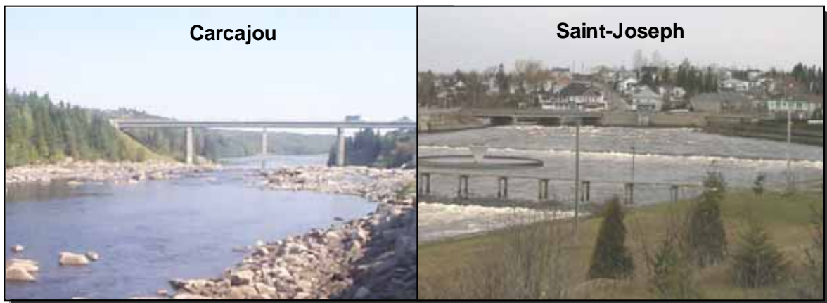
Figure 2.4 Pont Carcajou et pont Saint-Joseph
