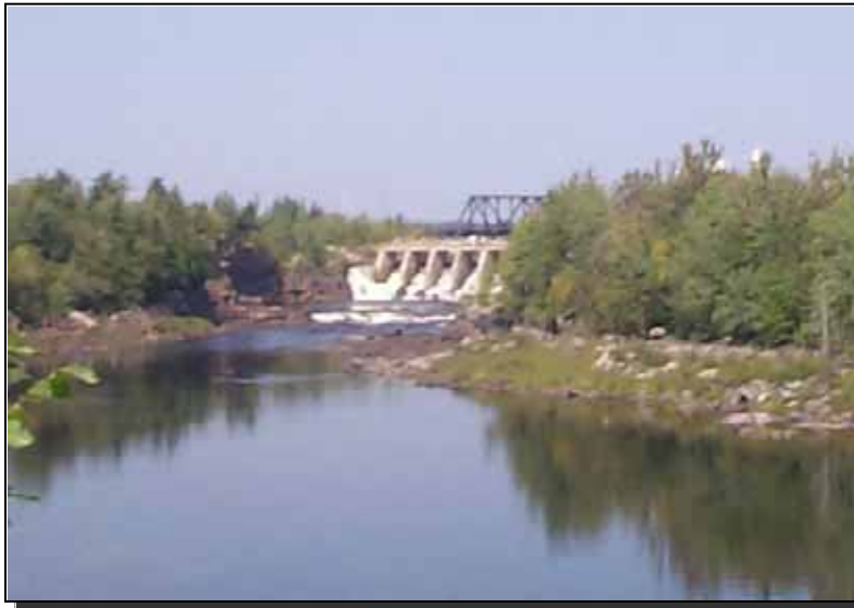
Figure 2.5 Barrage Sainte-Anne et pont ferroviaire
