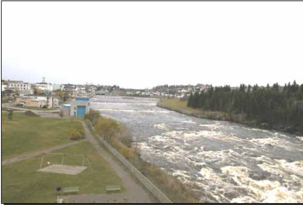
Figure 4.3 Tronçon 3 compris entre la passerelle existante et le poste de pompage
