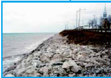
Vue vers l'ouest, falaise de matériaux granulaires protégée par un empierrement sur une distance de près de 870 m dont un secteur de 570 m réalisé sous décret d'urgence en 1997.
