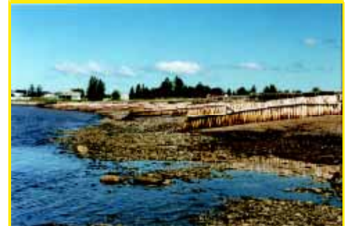
Vue vers l'ouest, plages de 500 m et flèche littorale de 1 km constituant des zones d'accumulation des matériaux de débris provenant des falaises en érosion. Le déficit sédimentaire occasionné par les ouvrages de protection pourrait expliquer l'érosion de plus de 400 m de plage où la mise en place d'épis et de murs n'arrive pas à contrer le phénomène.
