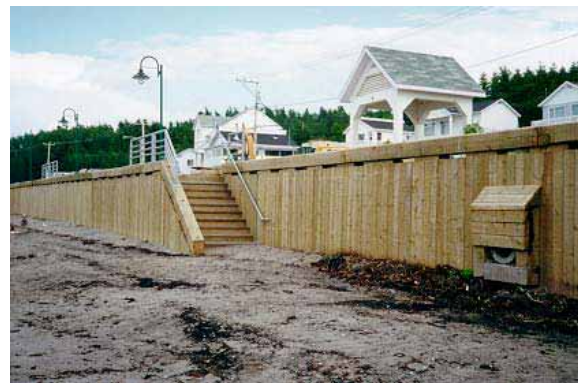
Exemple d'un mur et insertion d'un accès à la plage Sainte-Luce.
