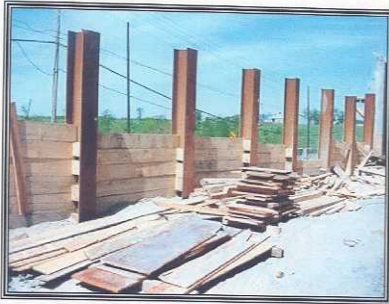
Type : Berlinois avec parement en bois (soutènement temporaire, construction d'un pont) Municipalité : Mascouche
