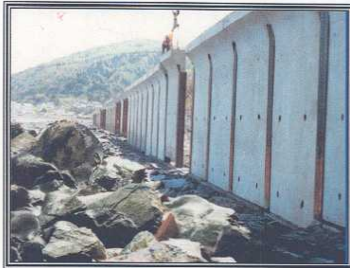
Type : Berlinois parement béton Municipalité : secteur Manche-d'Épée, Gros-Morne
