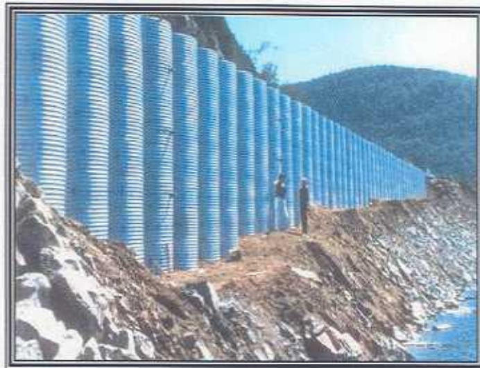
Type : Ter-voile tôle (mur à cellules ouvertes en tôle) Municipalité : Grandes-Piles
