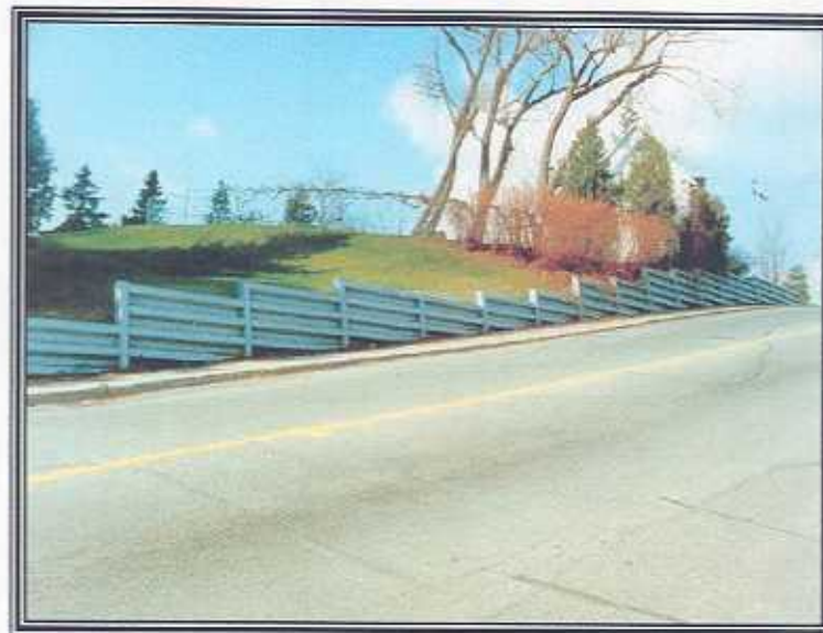
Type : Caisson en acier Municipalité : Baie-Comeau
