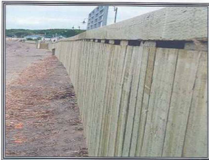
Type : Caisson en bois avec parement en bois Municipalité : Sainte-Luce
