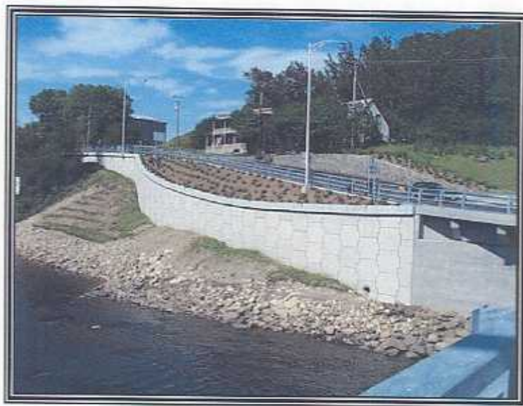
Type : Terre-armée (remblai renforcé par des armatures métalliques avec parement en béton) Municipalité : La Malbaie
