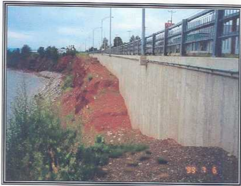
Type : Béton armé (porte-à-faux coulé sur place) Municipalité : Caplan
