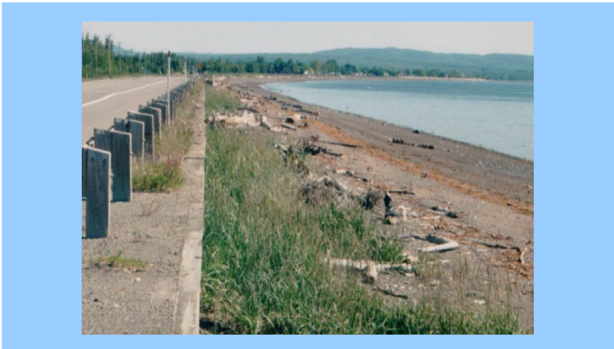
Figure 5 Petits épis réalisés sur la plage dans un secteur à l'est de la zone d'intervention
