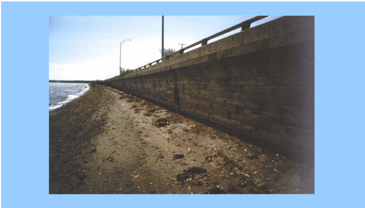
Figure 7 Mur de Maria avec déflecteur et garde-fou dans le secteur urbain, vue en direction ouest
