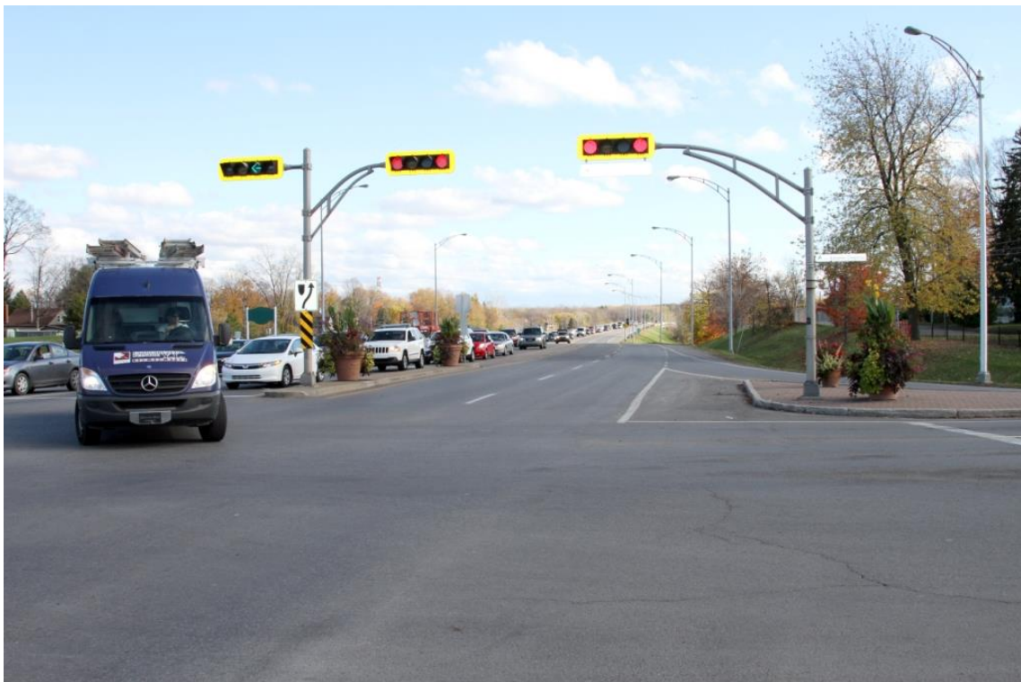
Photo 6 Intégration urbaine aux abords du boulevard Adolphe-Chapleau (vue vers le sud)
