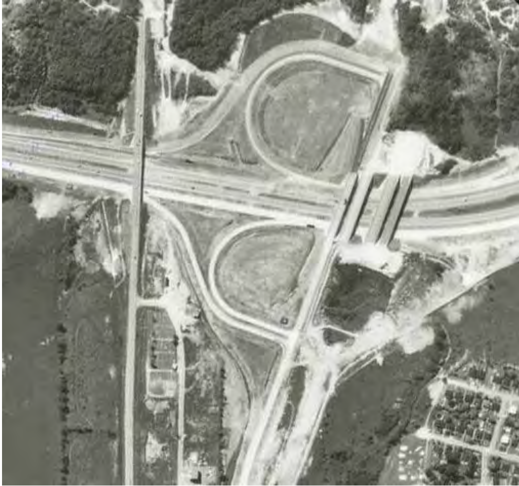
Échangeur et viaduc de la route 65, 1980
