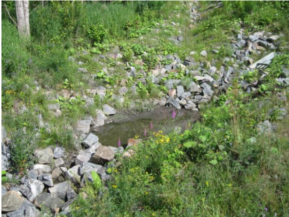
7 : Bassin de sédimentation du bassin 7-Ouest en 2009
