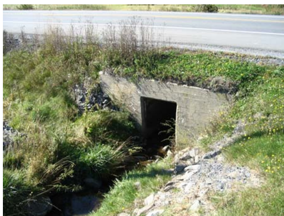
Ouvrage en amont de la route 173
