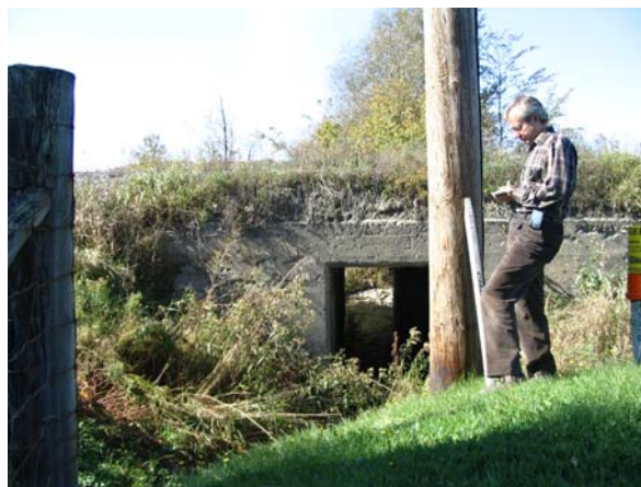
Ouvrage en amont de la route 173
