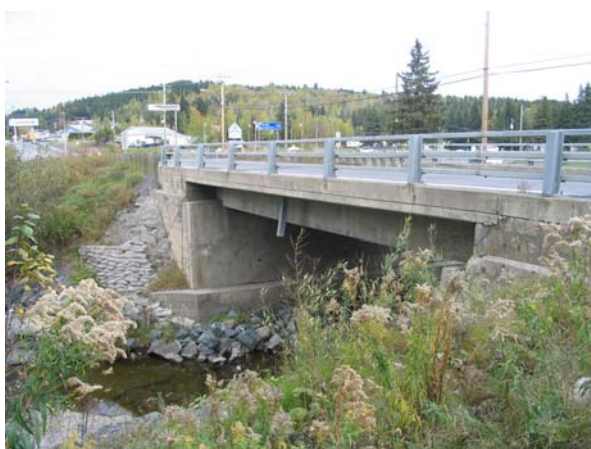
Ouvrage en aval de la rte 173
