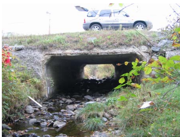
Ouvrage sous la route 173 (aval)
