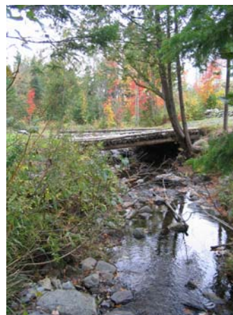
Pont en bois d'une hauteur de 1 000 mm (aval)
