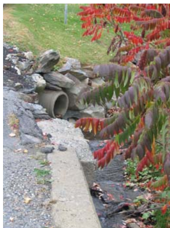
Drainage de fossé (côté amont)
