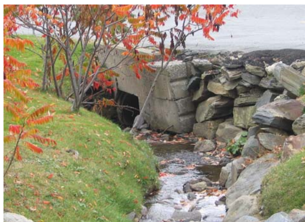
Ouvrage en amont de l'intersection
