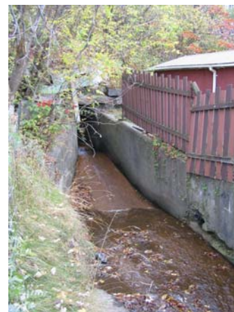
Ponceau côté aval de la voie ferrée
