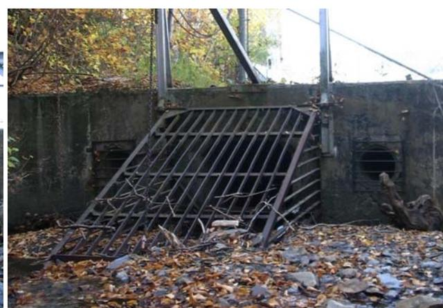
Grillages de retenu (débris) et conduites TBA (450 mm Ø)
