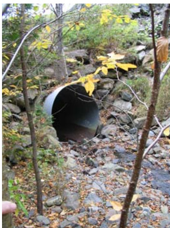
Côté amont de l'intersection
