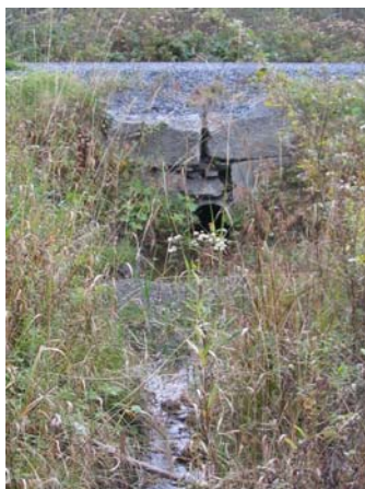
Ouvrage en aval, rang Saint-Charles
