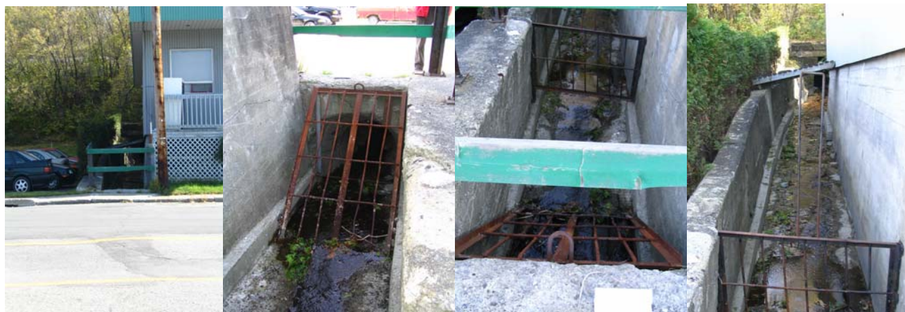
Localisation du canal Ouvrage amont, boul. Renault Grillages de retenu (débris) Cours d'eau (amont)
