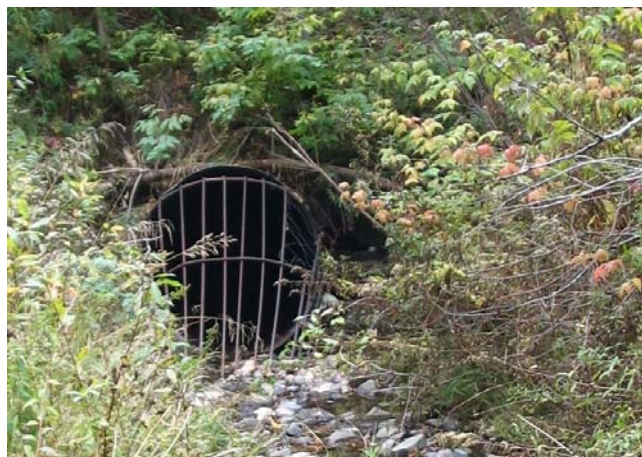
Ouvrage avec grille du côté amont de la 9 e Avenue
