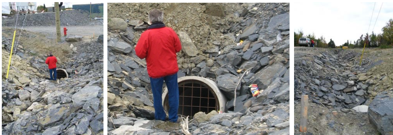
Ouvrage localisé en amont de la route (vue d'ensemble et agrandie)
