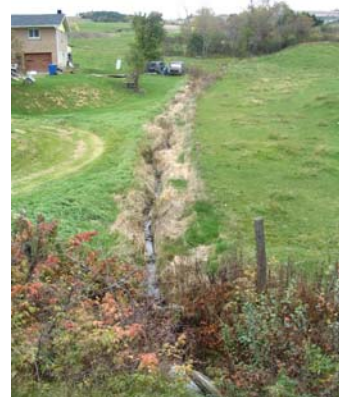
Cours d'eau (amont voie ferrée)
