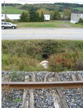
Route 173 (côté amont)
