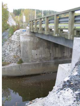
Ouvrage en aval, rte du Golf
