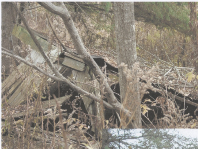
Figure 7 Photos des vieux bâtiments et de la petite niche à 'exproprier' par la variante de tracé Ouest
