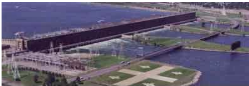
Figure 7. Une des plus grandes centrales hydroélectriques au monde à Beauharnois (1 657 MW) 17
