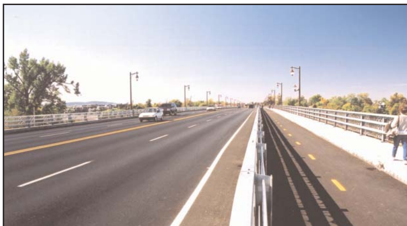
Structure avec piste cyclable et trottoir (Pont Jordi-Bonet)
