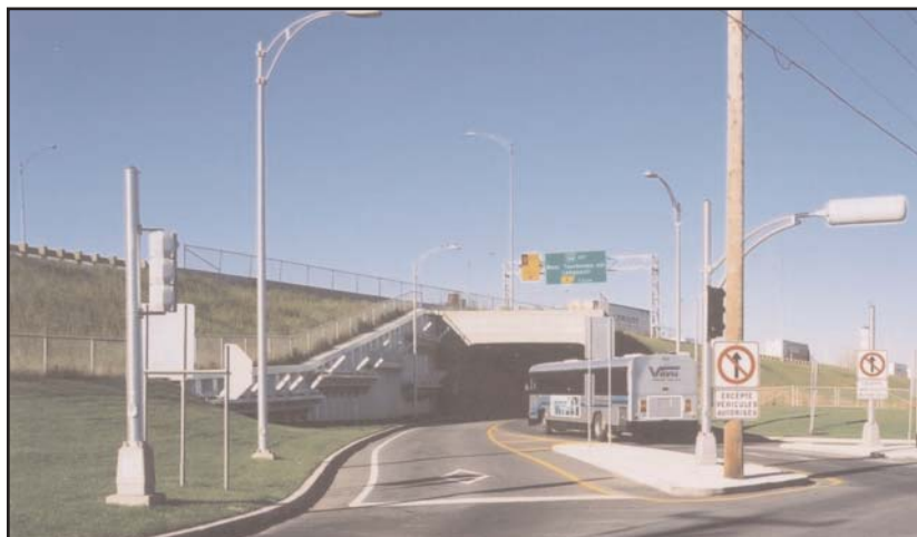
Tunnel reliant le stationnement incitatif Chevrier aux voies réservées pour autobus, autoroute 10, Longueuil
