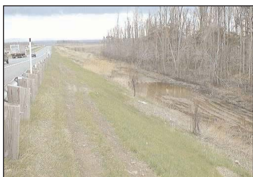
Sentier de VTT longeant l'autoroute en haut du talus Autoroute 10, Saint-Alphonse
