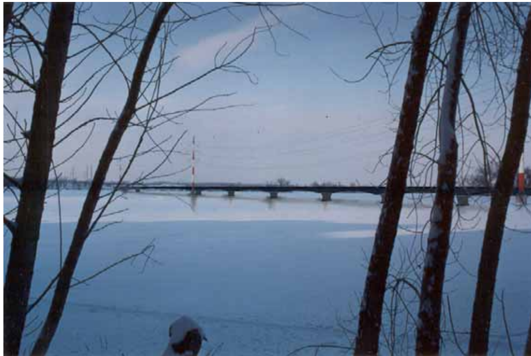
FIGURE G-2 Variante de pont à haubans – Vue de la rive sud
