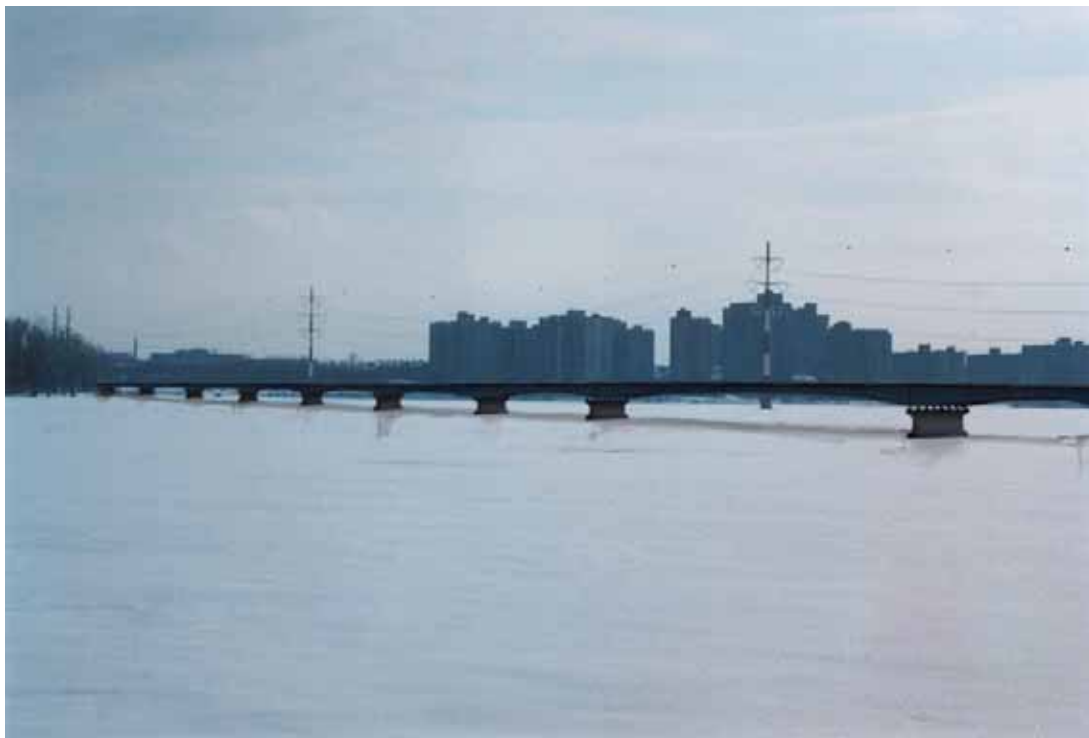
FIGURE G-1 Variante de pont à poutres précontraintes – Vue de la rive nord
