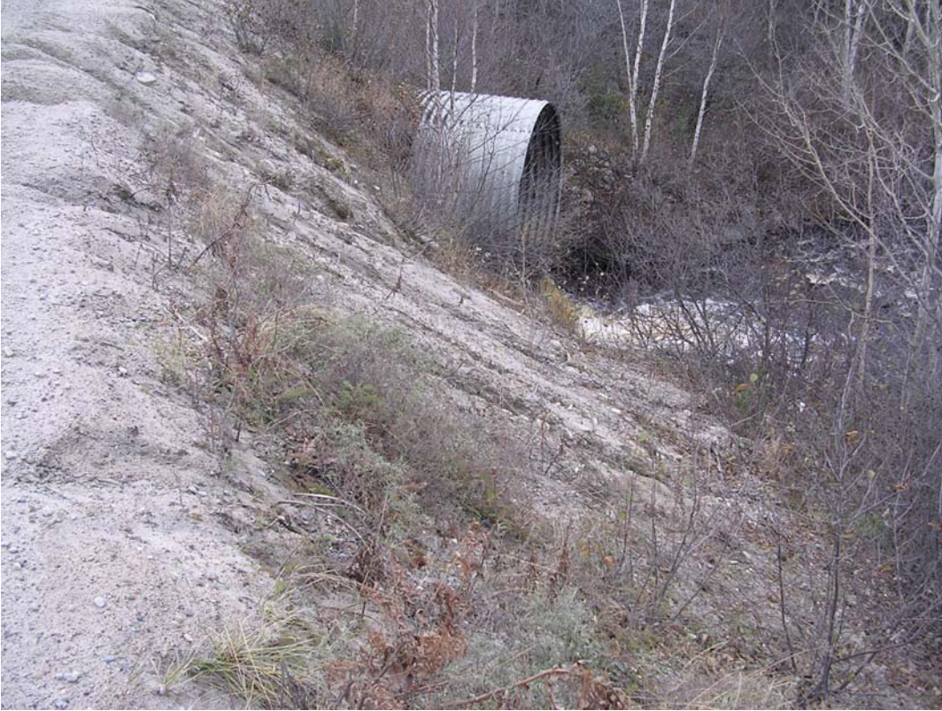
Fig. 8: Dynamique d'érosion très active aux abords d'un ponceau.
