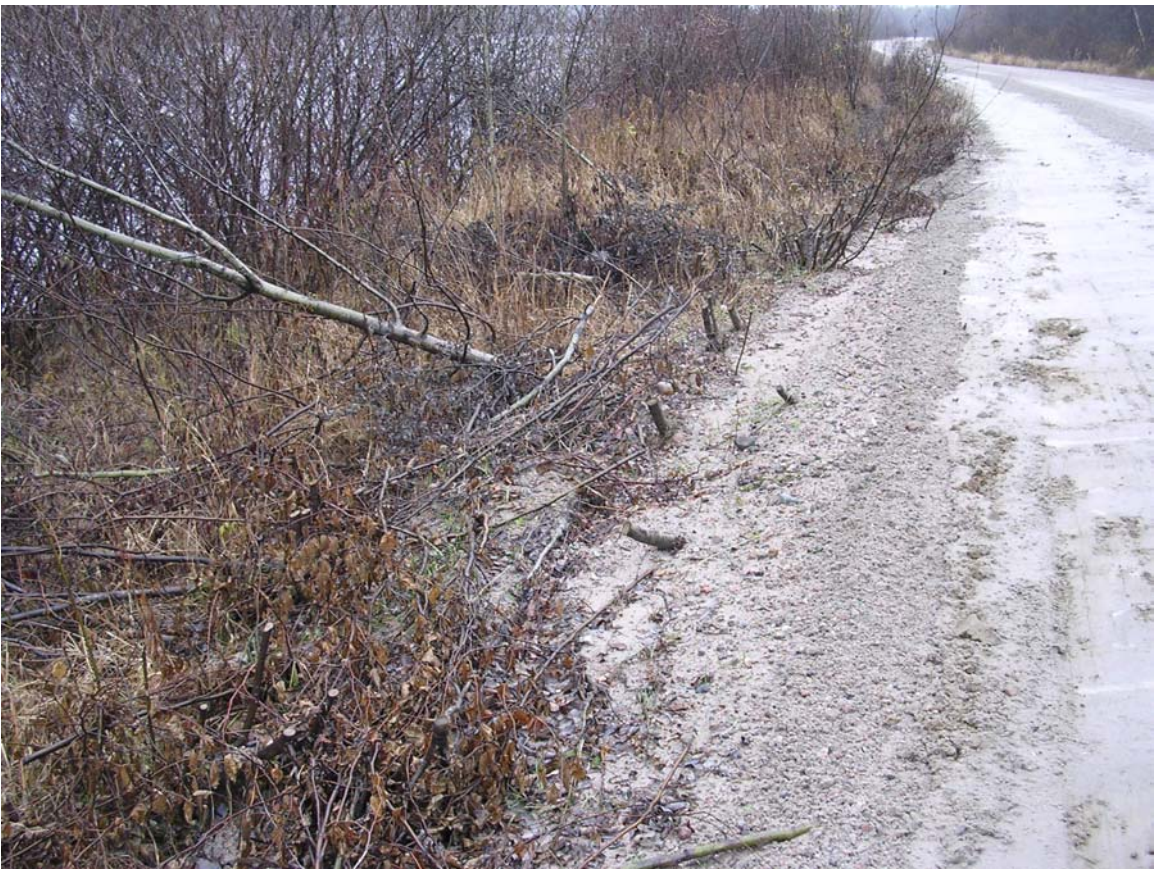
Fig. 3 : Apport de matériel observé suite au passage de la niveleuse.
