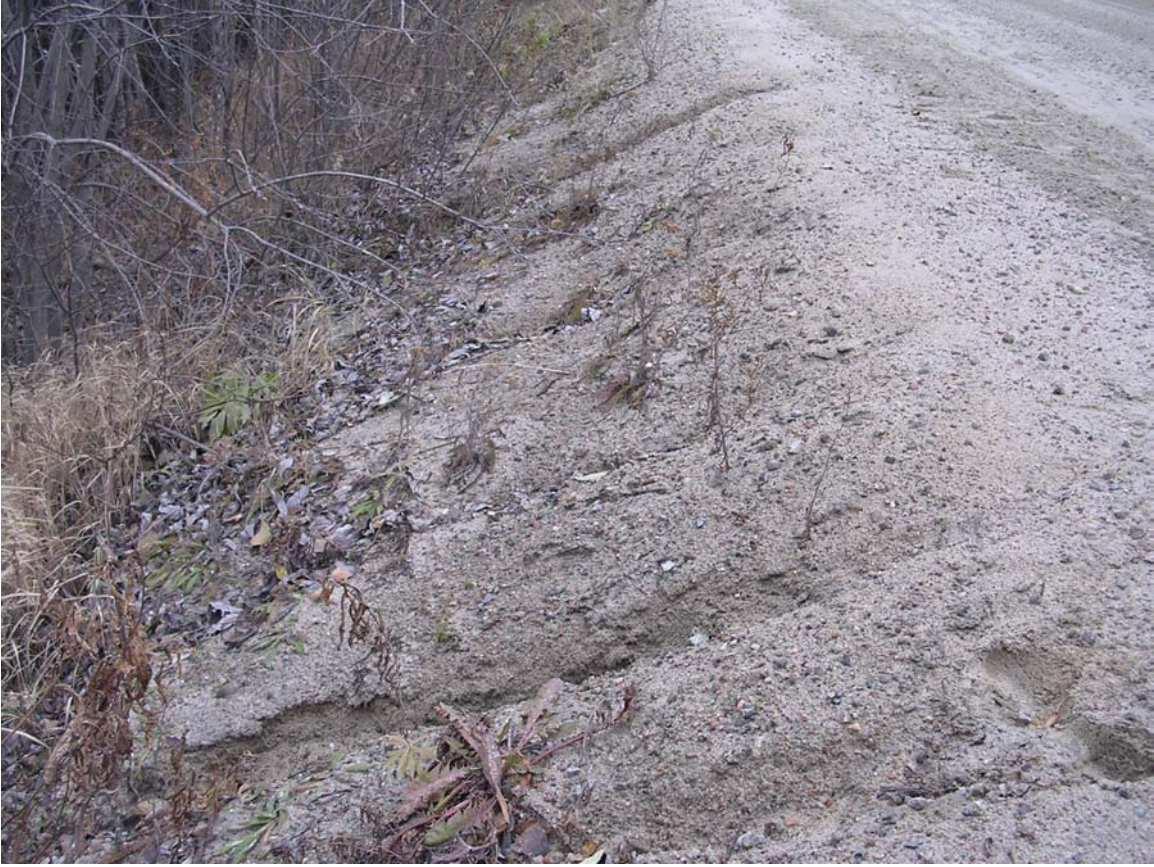
Fig. 4 : Rigoles d'érosion observées dans un segment de bande riveraine de moins de dix mètres.
