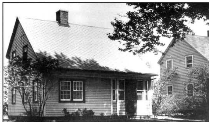
Parmi les innovations arvidiennes, des couvertures en aluminium, dont celle-ci, sur une maison de type A4.
