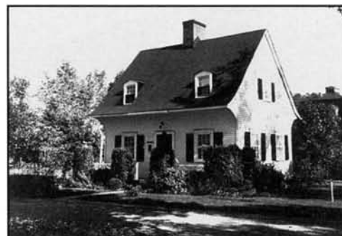
Vers 1950, une des maisons du type A-5 conçu en 1937 par Léonce Desgagné
