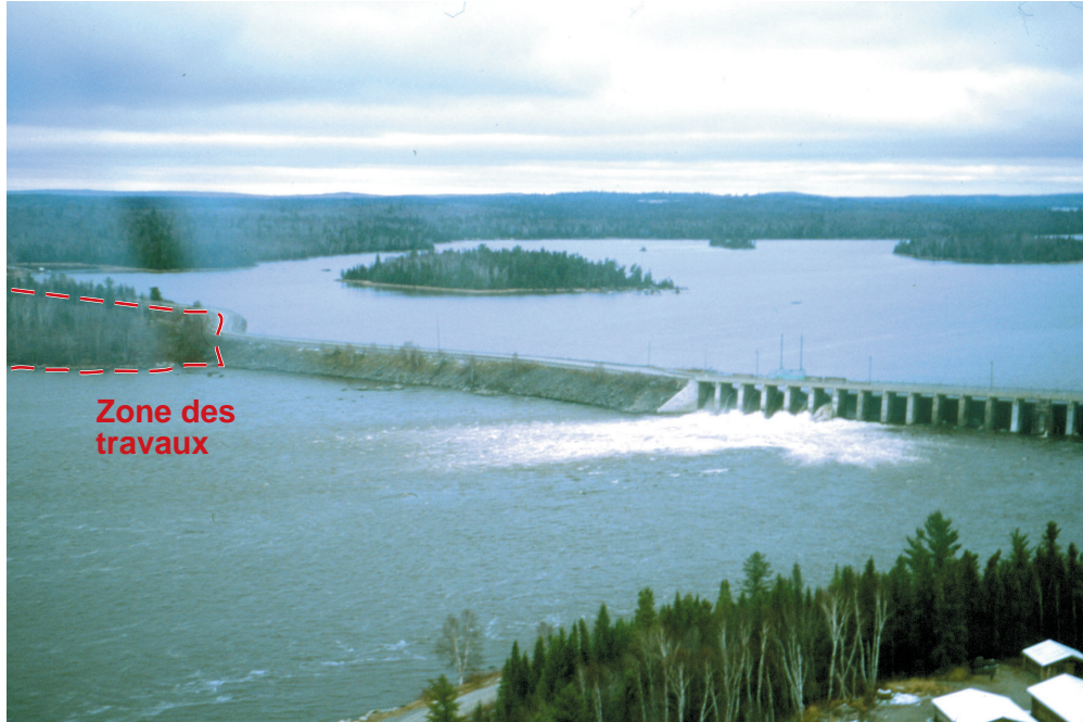
Vue du barrage des Quinze et de la zone des travaux à partir de la municipalité d'Angliers.
