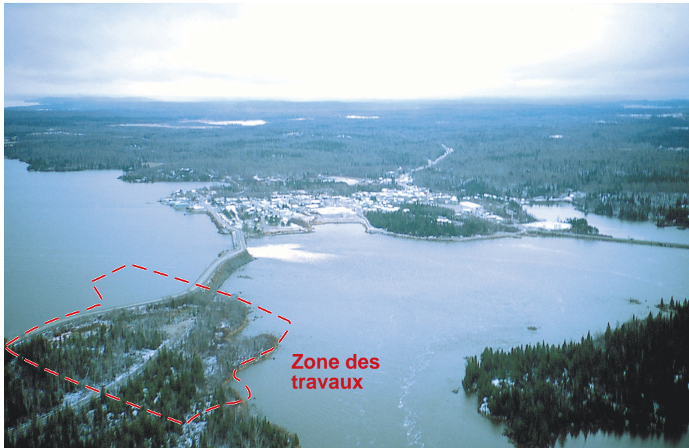
Vue de la zone des travaux, du barrage des Quinze et de la municipalité d'Angliers à partir de la rive droite de la rivière des Outaouais.
