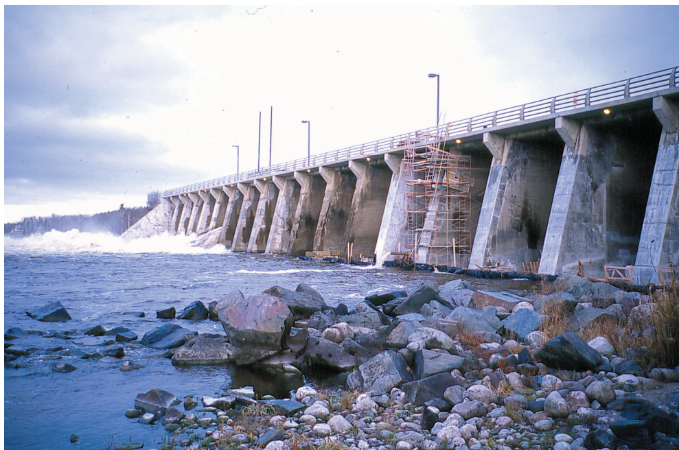
Photo 2 Évacuateur du barrage des Quinze.
