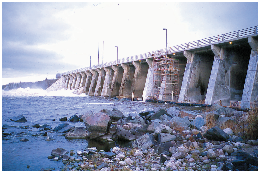
Photo 2 Évacuateur du barrage des Quinze.
