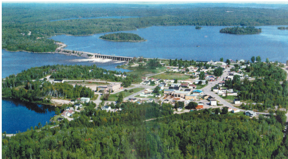
Photo 1 Vue d'ensemble de la municipalité d'Angliers, du barrage et du réservoir des Quinze.
