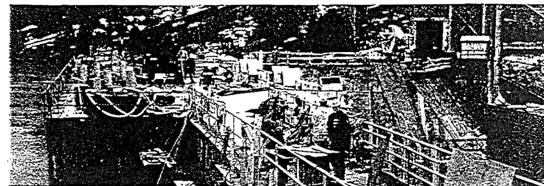
Travaux sur le tablier du barrage (rive droite) de la centrale des Rapides-des-Quinze. Photo prise le 05/12/2001.
