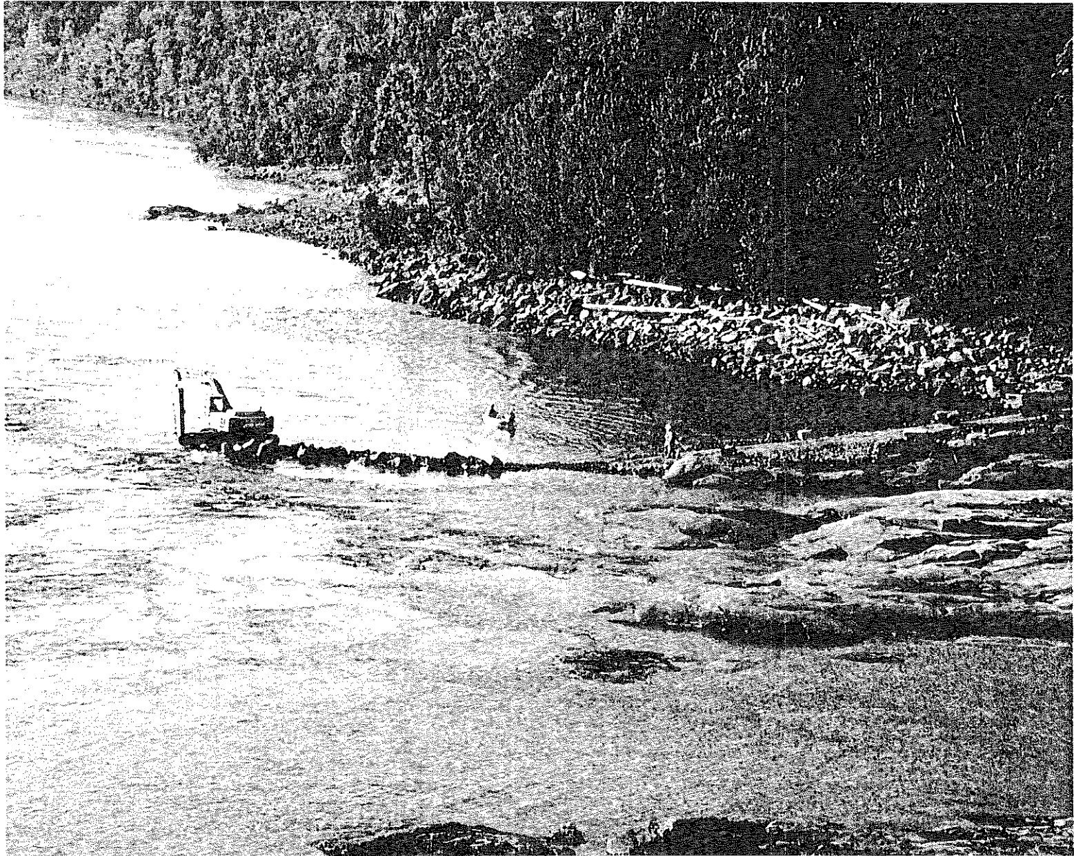
Démantèlement du chemin d'accès (vue du barrage)
