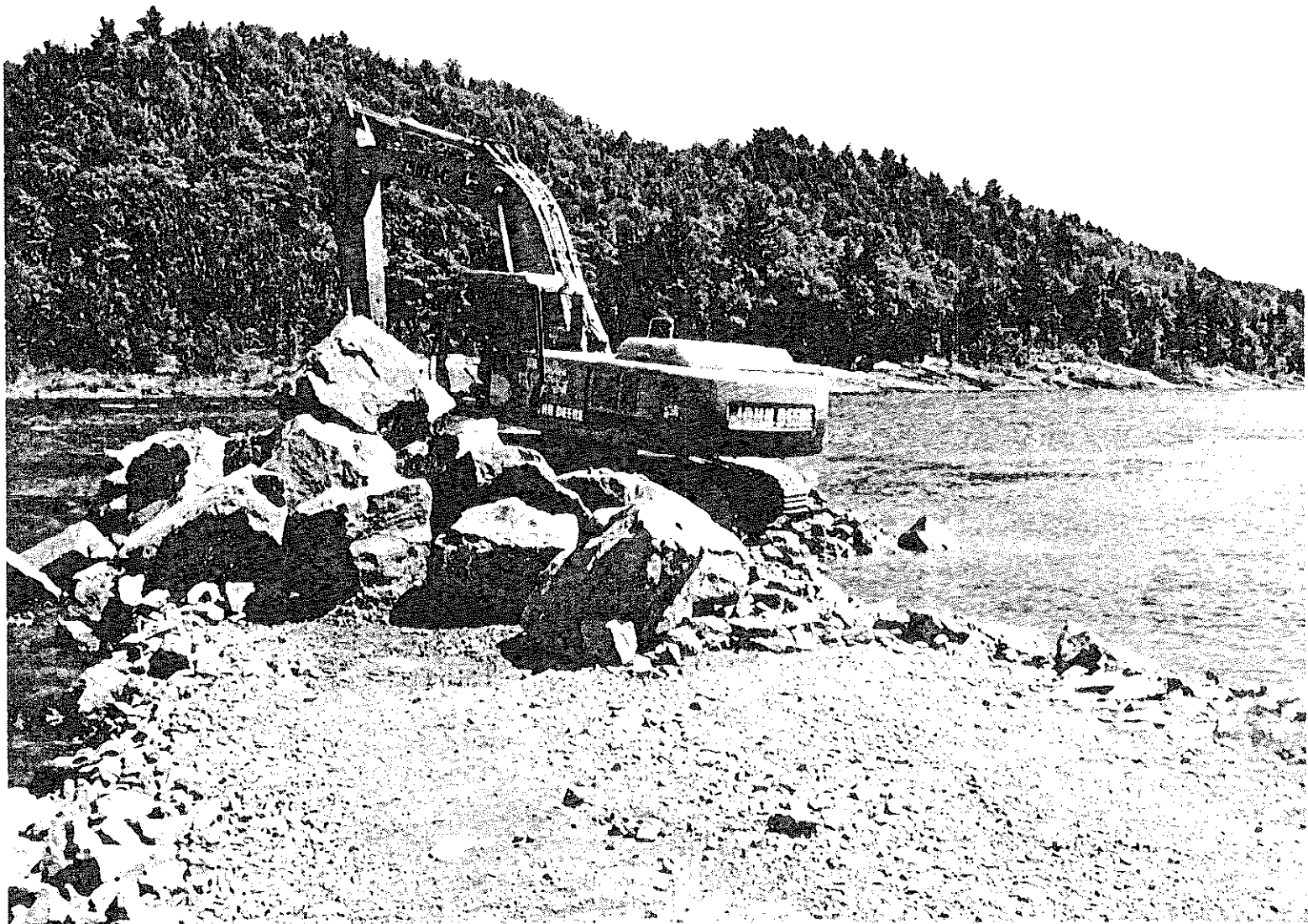
Aperçu des blocs utilisés pour construire les abris de courant
