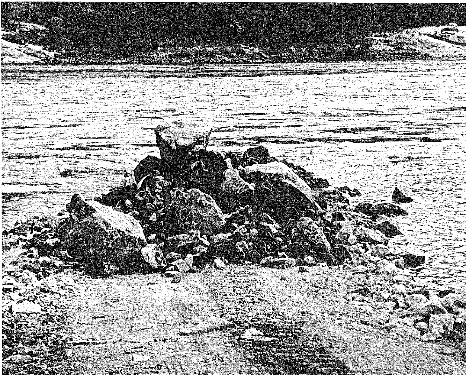
Aperçu des différents matériaux destinés à l'aménagement de la frayère
