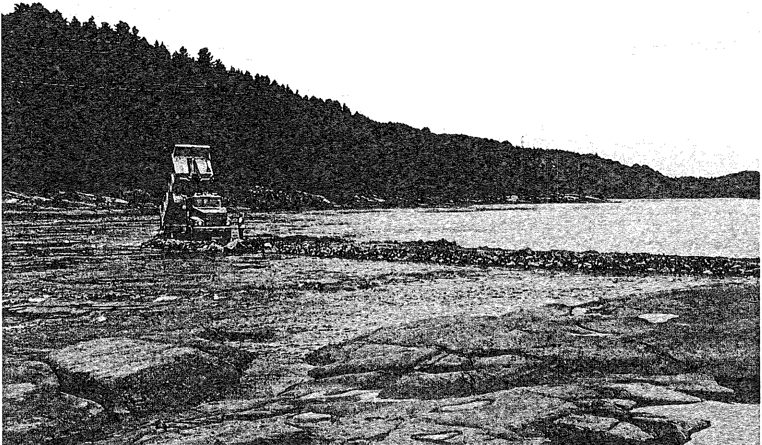
Acheminement des matériaux
