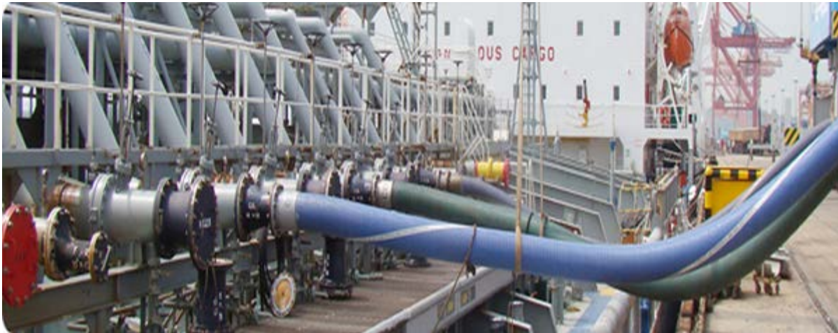
Illustration 4-3 : Exemple d'un boyau de déchargement des navires-citernes et de chargement des barges
