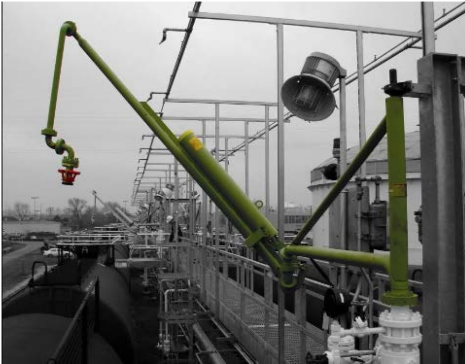
Illustration 4-6 : Bras de chargement typique utilisé pour remplir les wagons-citernes et passerelle
