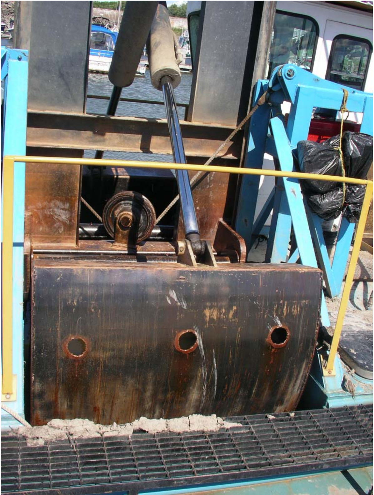
Photo 3.2 Vue rapprochée du godet de la benne preneuse
