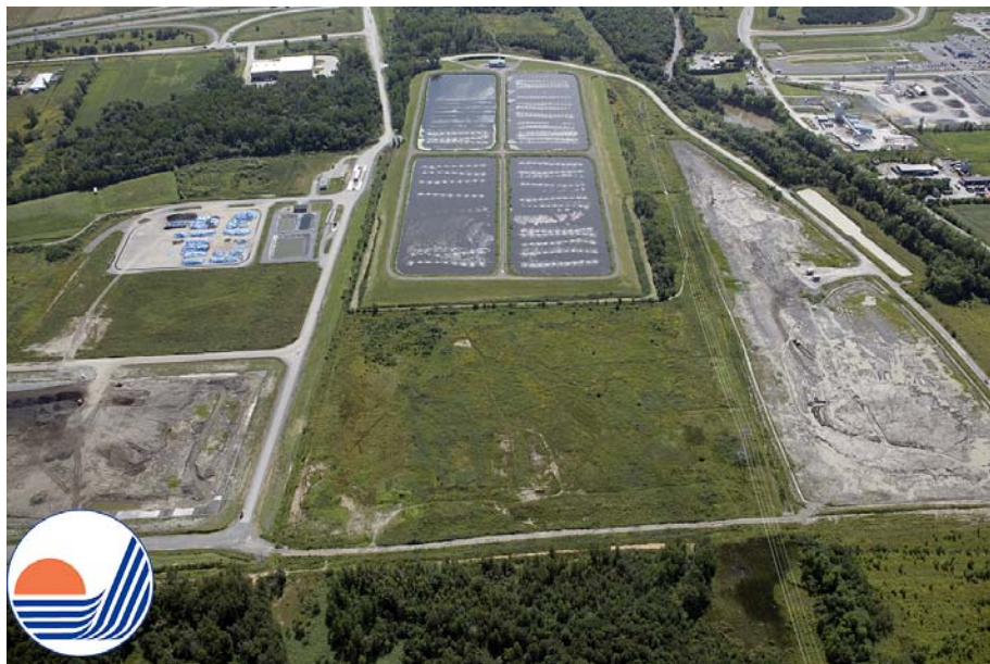
FIGURE 1.1 : COMPLEXE ENVIRONNEMENTAL LES MOULINS
