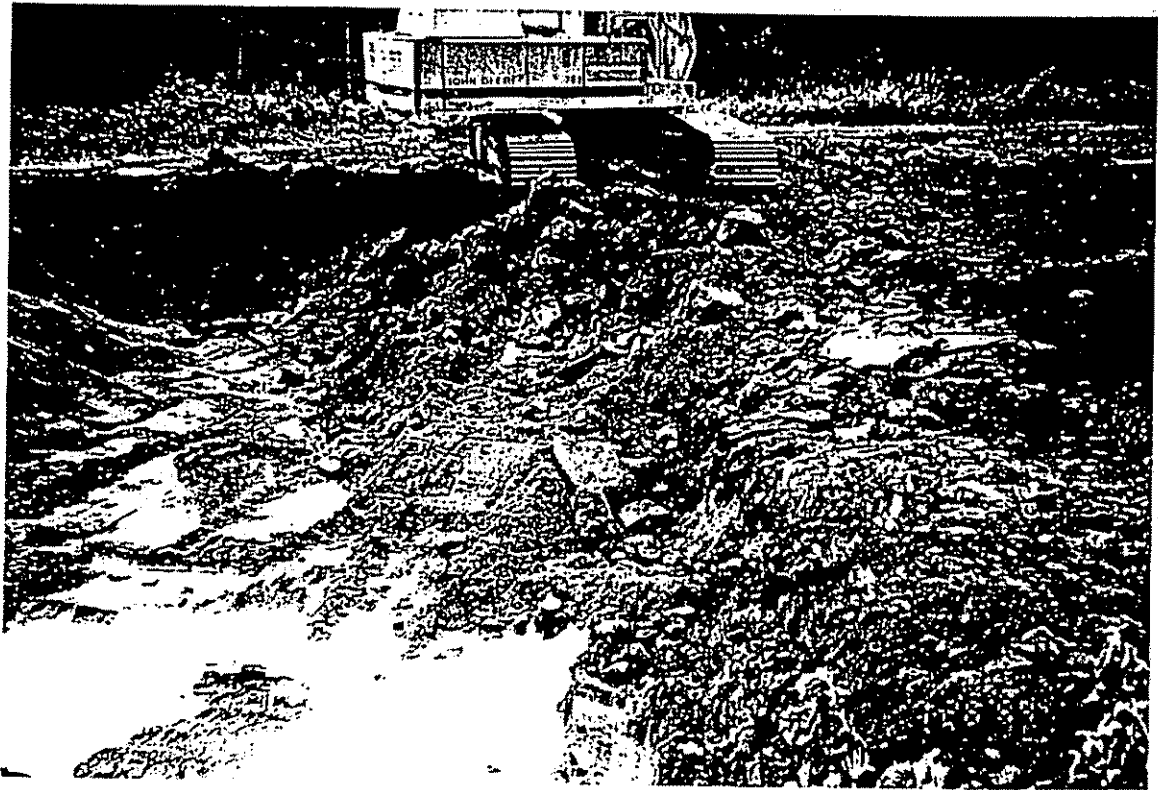
Excavation de la plaque 6
