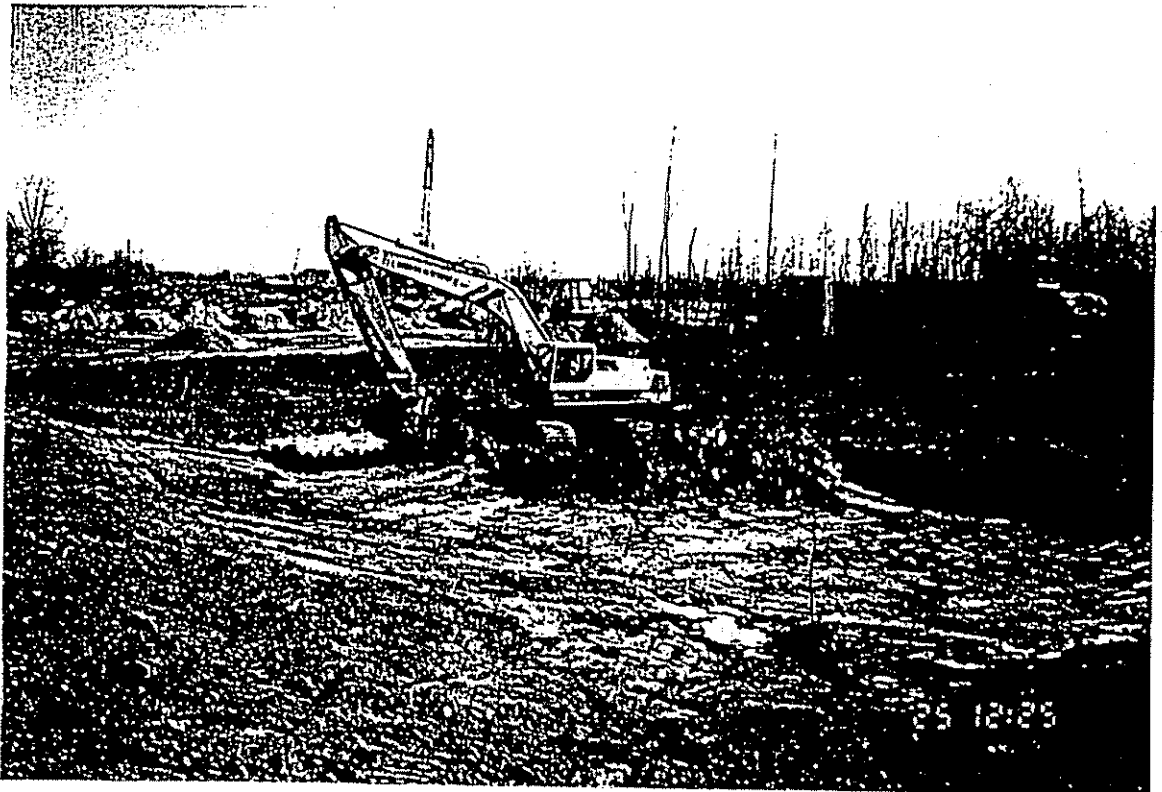
Construction des digues du LP1
