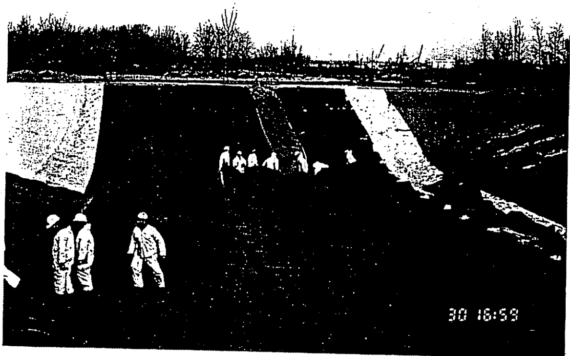
Mise en place de la 2 ème géomembrane dans le LP1
