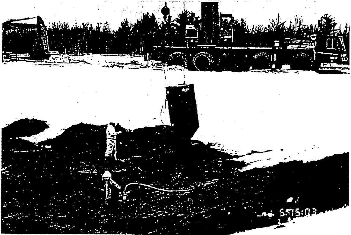
Mise en place du sable au fond et sur les parois du LP1
