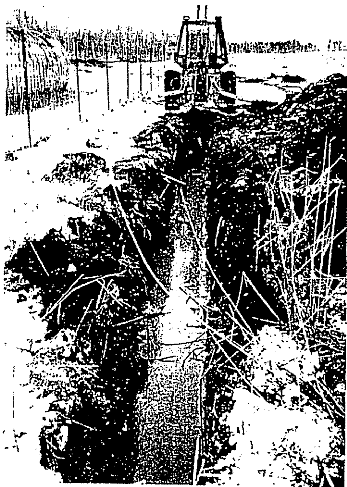
Excavation de la paroi étanche autour du parc des réservoirs
