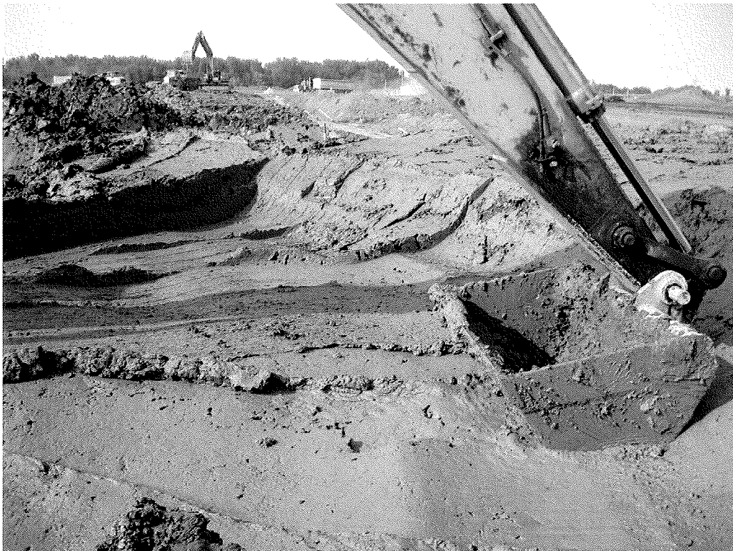
PHOTO N° 2 Mise en place
