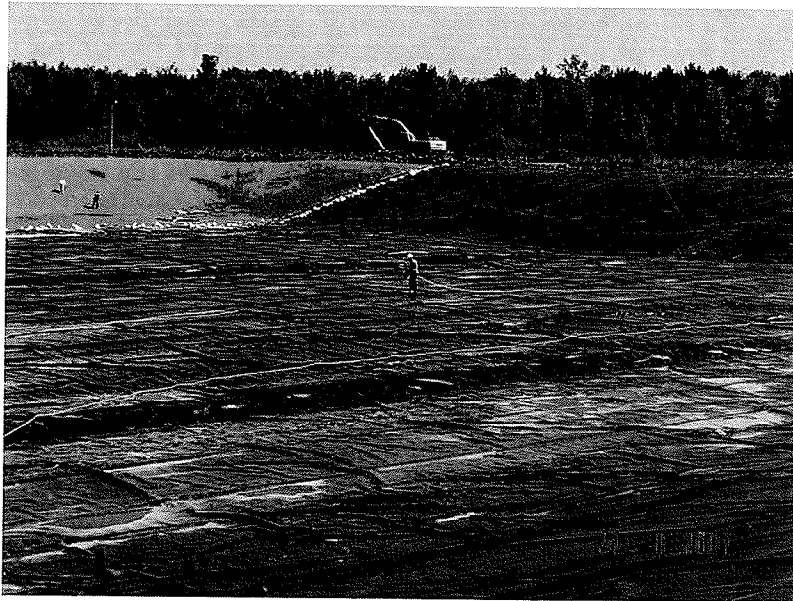
Photo n° 15 : Détection de fuites au jet d'eau sur géomembrane exposée
