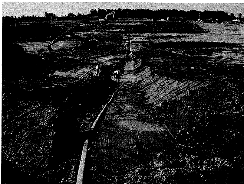
Photo n° 6 : Excavation de la tranchée centrale pour mise en place du système de drainage de détection de fuites
