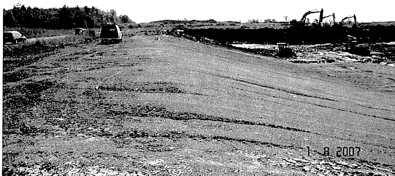
Photo n° 8 : Régalage et lissage des talus
