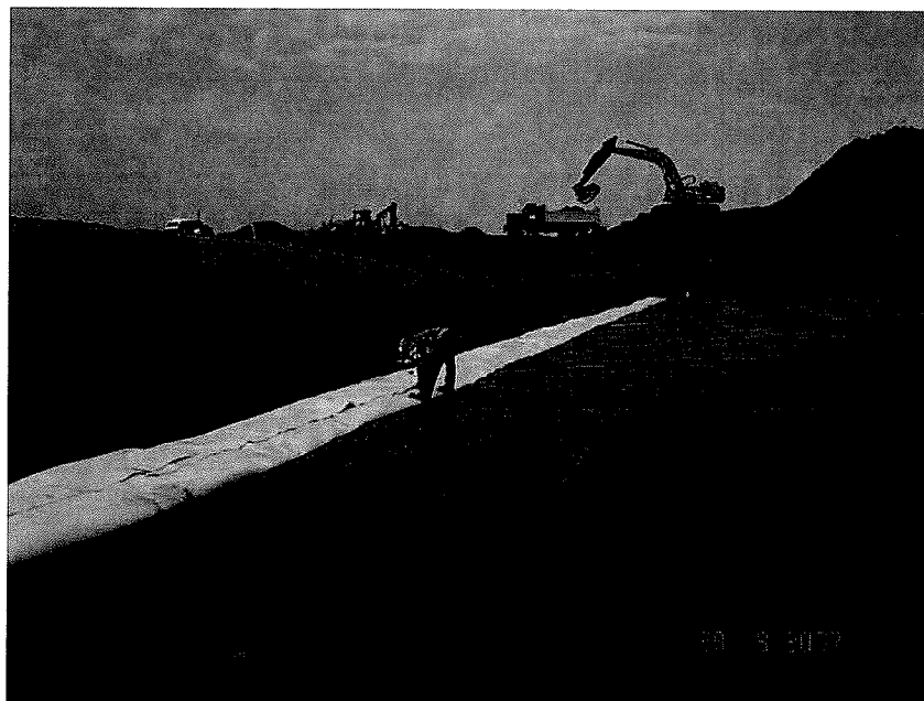
Photo n° 21 : Vue du chemin d'accès et d'une tranchée de drainage
