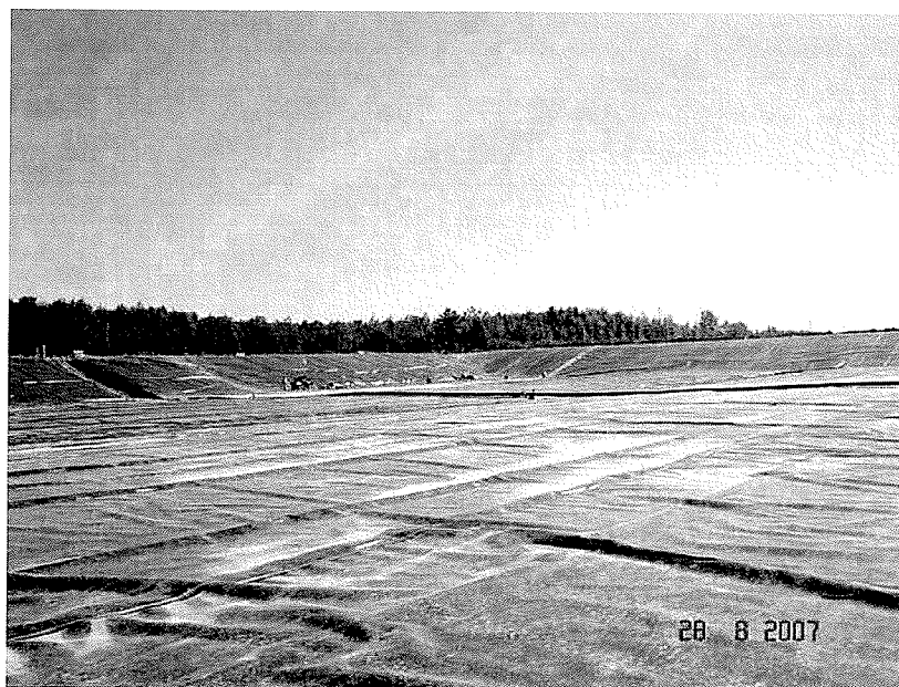
Photo n° 14 : Géomembrane inférieure sur fond et talus de la cellule phase 2
