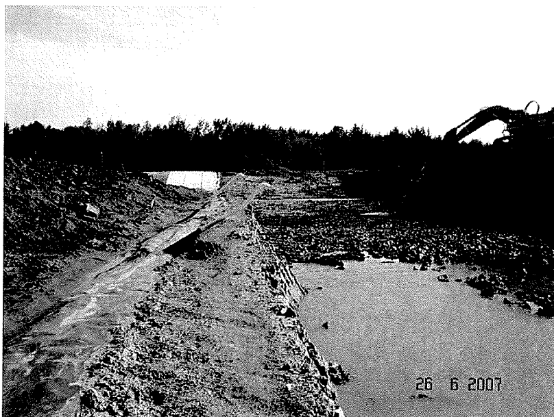
Photo n° 5 : Excavation de masse à proximité de la cellule existante (phase 1)
