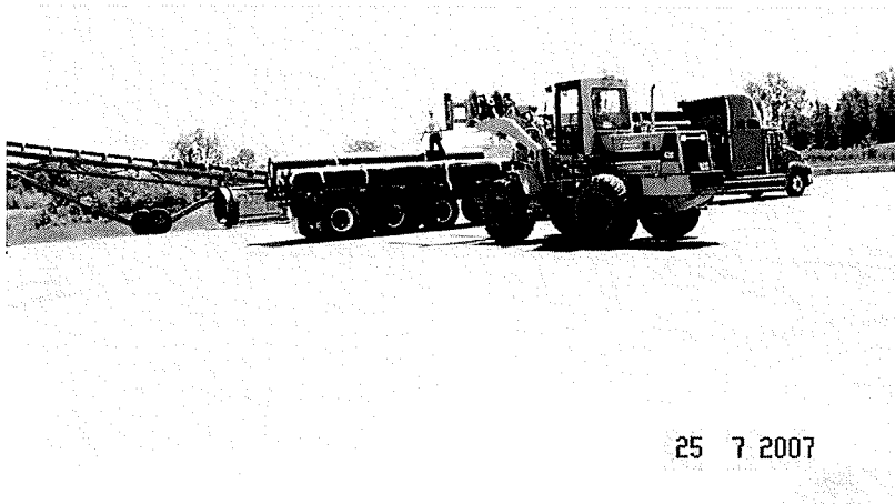
Photo n° 10 : Opération de déchargement des rouleaux de géomembrane
