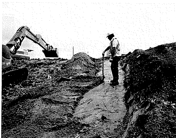
Photos n os 3 et 4 : Dégagement de la géomembrane au droit de la cellule existante (phase 1)
