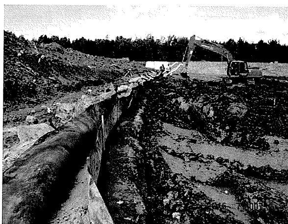
Photos n os 3 et 4 : Dégagement de la géomembrane au droit de la cellule existante (phase 1)
