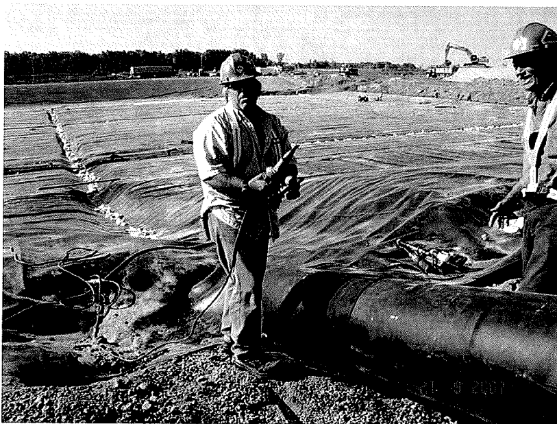
Photo n° 13 : Travaux de soudures – tranchée de collecte principale
