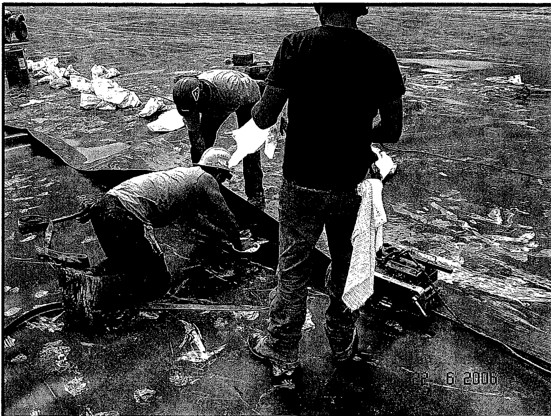
Photo 11 : Soudures doubles.
