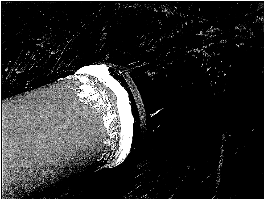
Photo 13 : Étanchéité d'une conduite de PVC.
