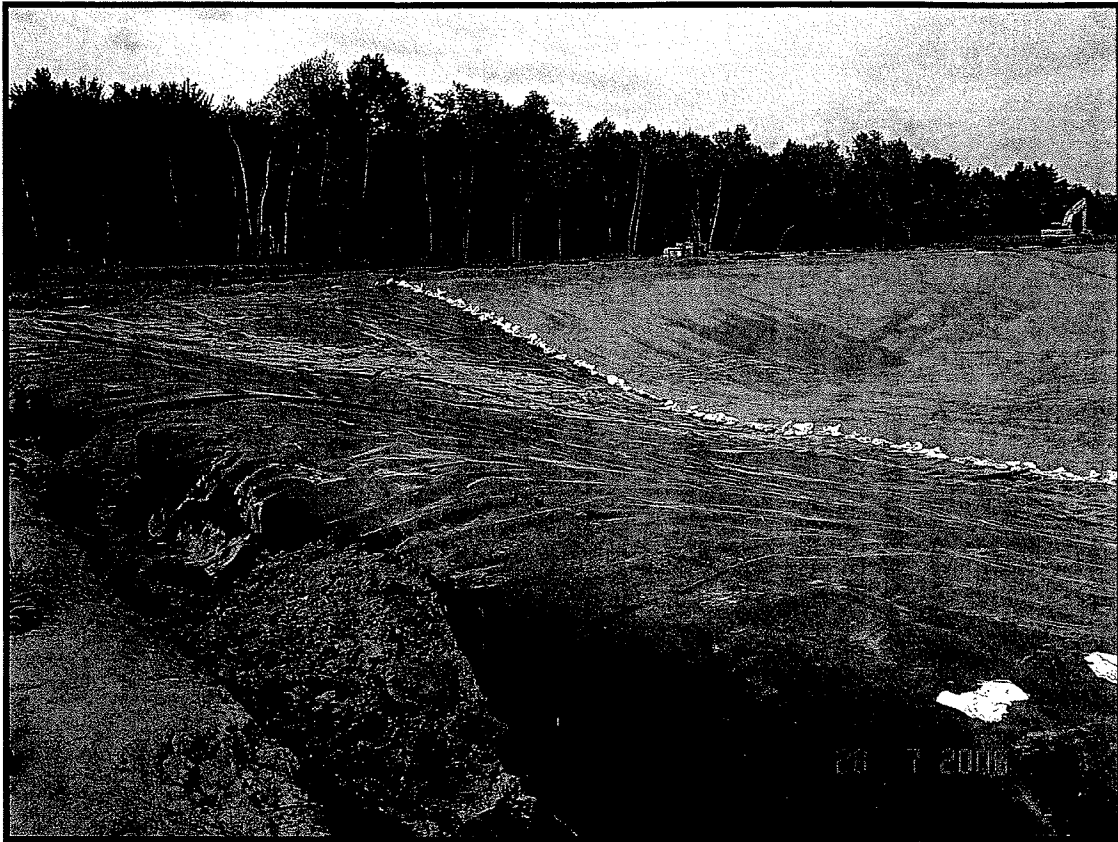
Photo 6 : Vue de la clé d'ancrage du secteur ouest de la cellule.
