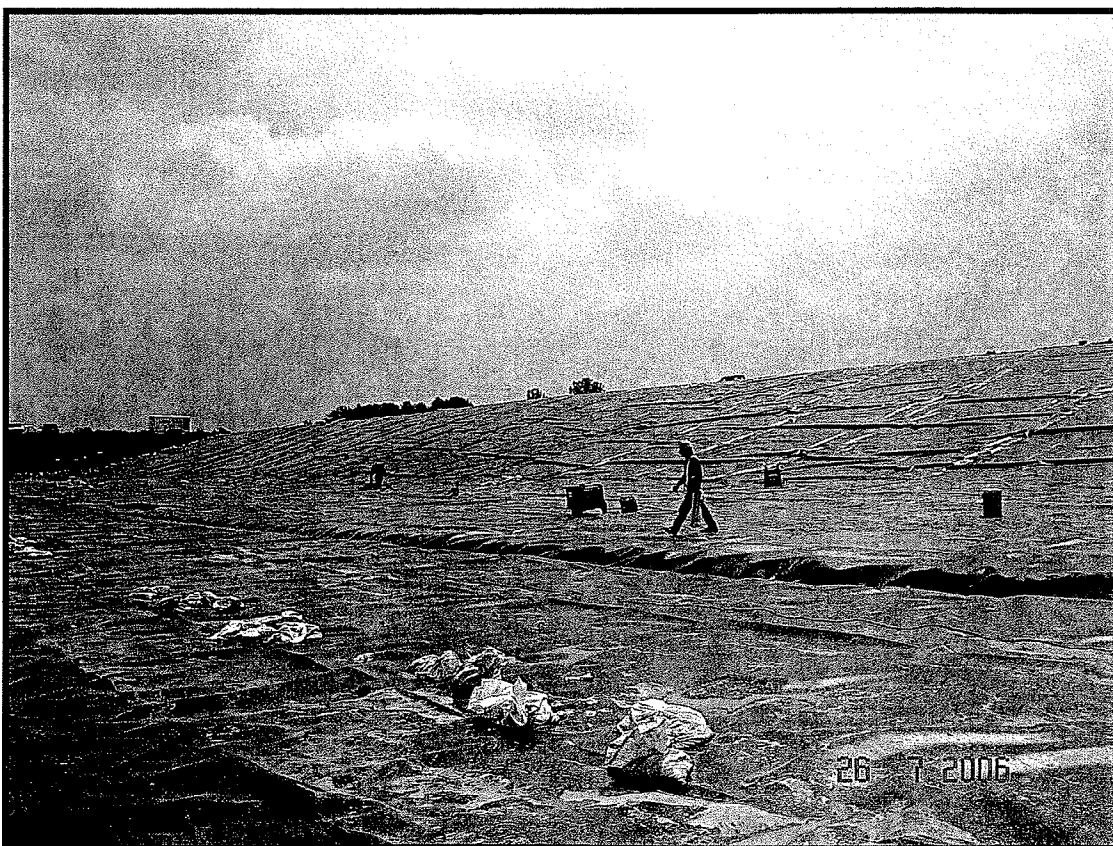
Photo 5 : Vue du talus sud de la cellule.
