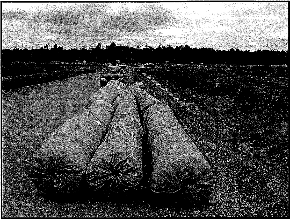
Photo 14 : Entreposage des rouleaux de géocomposite bentonitique.
