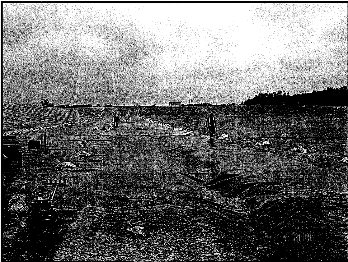
Photo 7 : Installation de la géomembrane sur les tranchées transversales.
