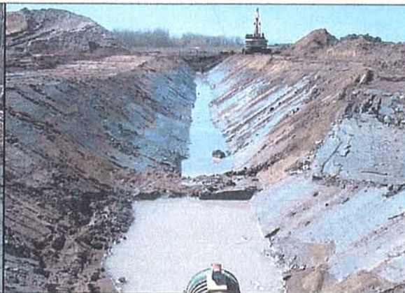
Fossé FP-2 (périphérique ouest) vue vers le sud (5 mai 2005)
