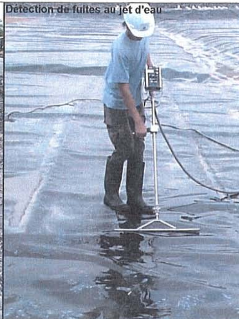
Détection de fuites au jet d'eau sur géomembrane inférieure (3 juillet 2006)
