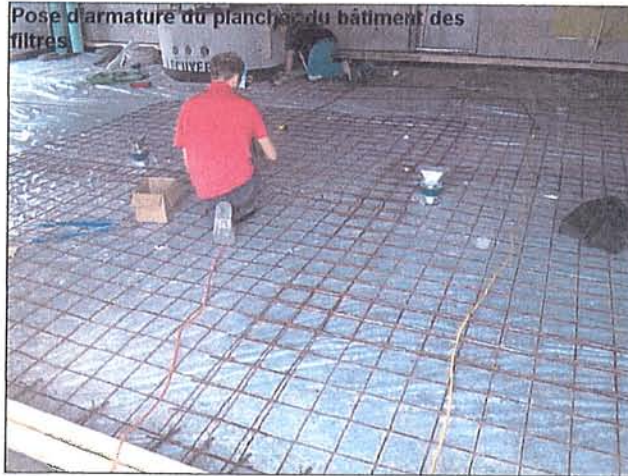
Armature de la dalle de plancher (22 août 06)
