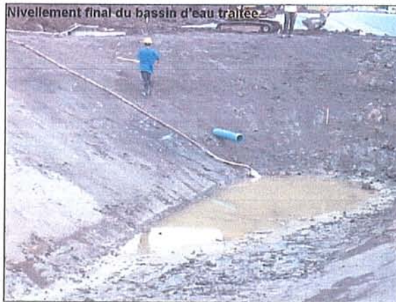
Nivellement final du bassin d'eau traitée (25 juillet 2006)
