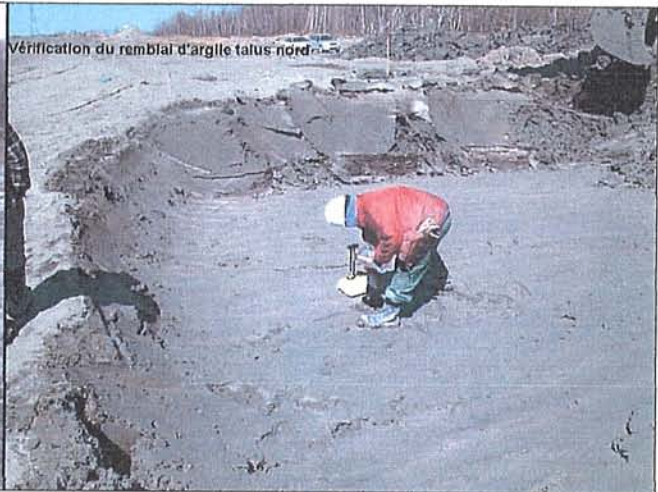
Vérification de la compaction remblai d'argile talus nord (28 avril 2006)
