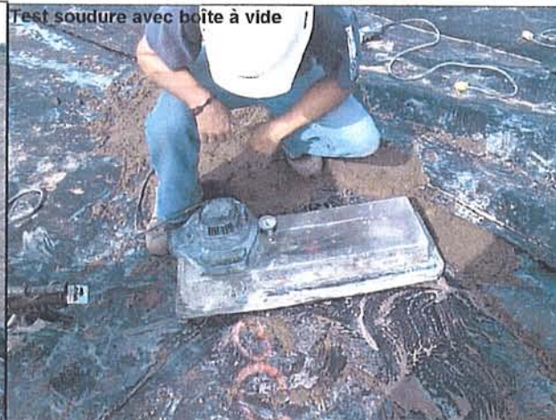
Test avec boîte à vide d'une soudure par extrusion
