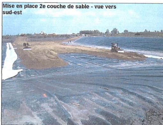
Mise en place de la 2 e couche de sable sur géomembrane supérieure -(1 er août 2006)
