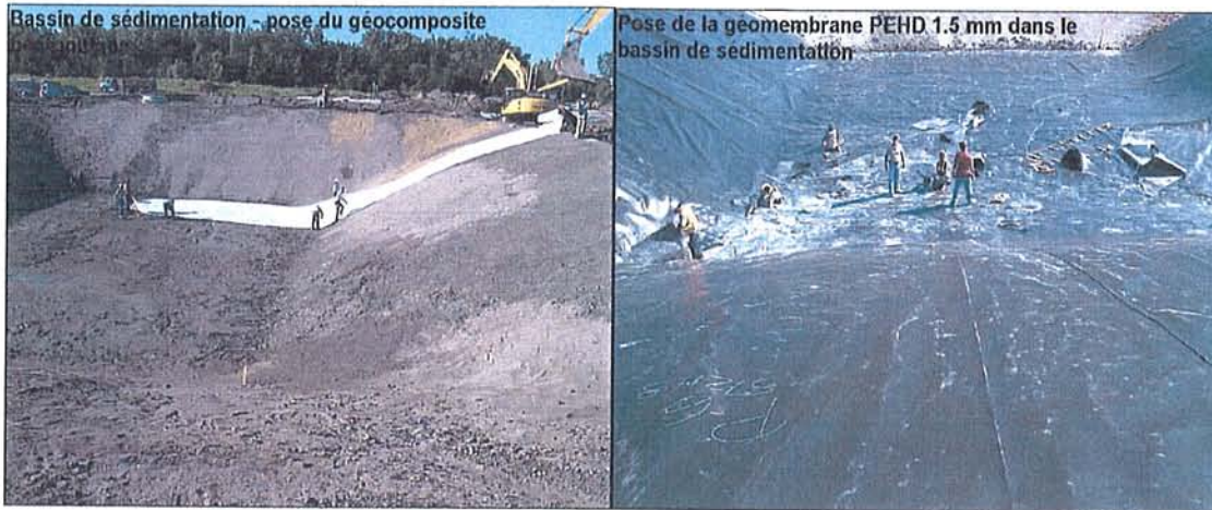
Pose du géocomposite bentonitique dans le bassin de sédimentation (19 juillet 2006)
