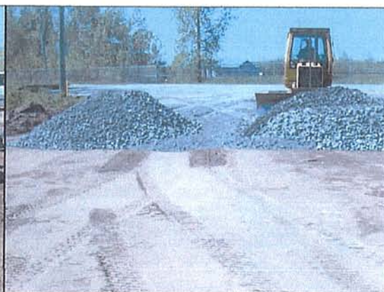
Empierrement route de service no.1- entrée du site (25 mai 2005)
