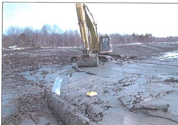
Réalisation de la planche d'essai de compaction de l'argile –berme ouest (7 mars 2006)
