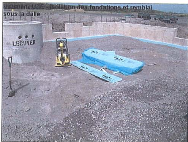
Isolation des fondations et remblai en pierre concassée (17 juillet 06)
