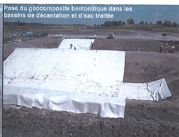
Pose du géocomposite bentonitique dans les bassins d'eau traitée et de décantation (3 août 2006)
