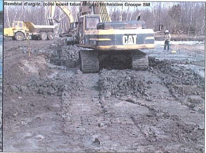
Vérification de la compaction de l'argile berme ouest (22 mars 2006)
