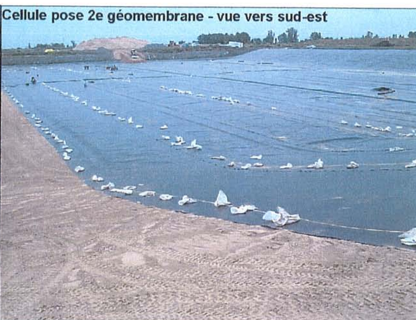
Pose de la géomembrane supérieure – (28 juillet 2006)
