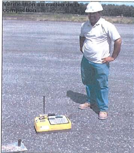
Vérification de la compaction au nucléodensimètre (30 juin 2006)
