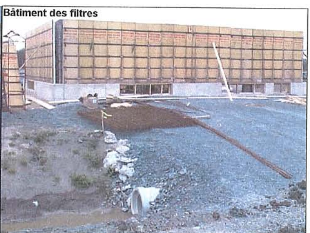
Coffrage des murs (4 août 06)
