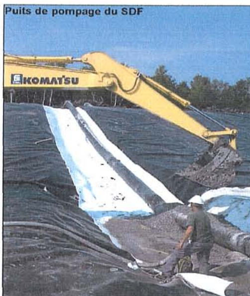
Installation du puits de pompage SDF
