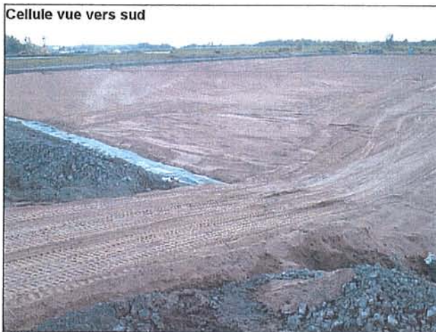
1 re couche de sable sur géomembrane inférieure – (11 juillet 2006)
