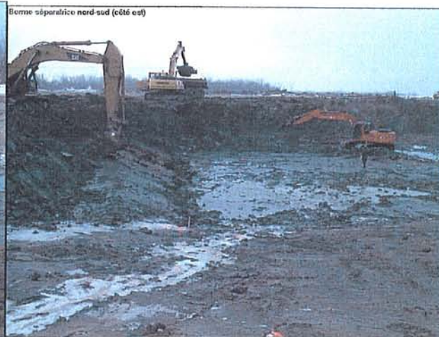
Excavation de la cellule (berge séparatrice nord-sud (côté est) (13 fév 2006)
