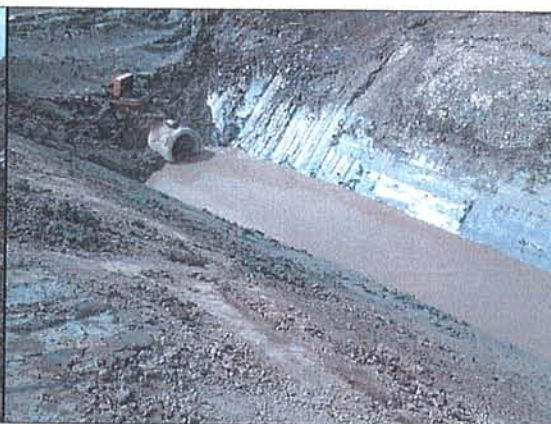
Sortie du réseau pluvial (tuyau installé dans regard existant – fossé reprofilé longeant servitude d'Hydro-Québec (12 avril 2005)
