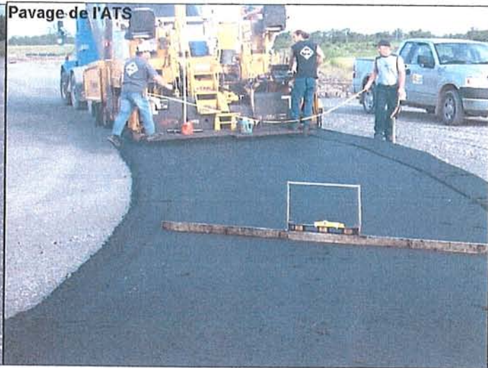
Mise en place de l'asphalte (3 juillet 2006)
