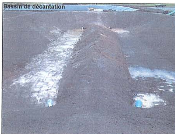
Bassin de décantation avant la pose des géosynthétiques (26 juillet 2006)
