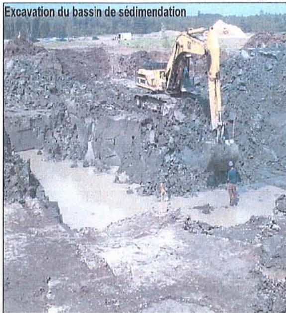
Début de l'excavation du bassin de sédimentation (29 juin 2006)
