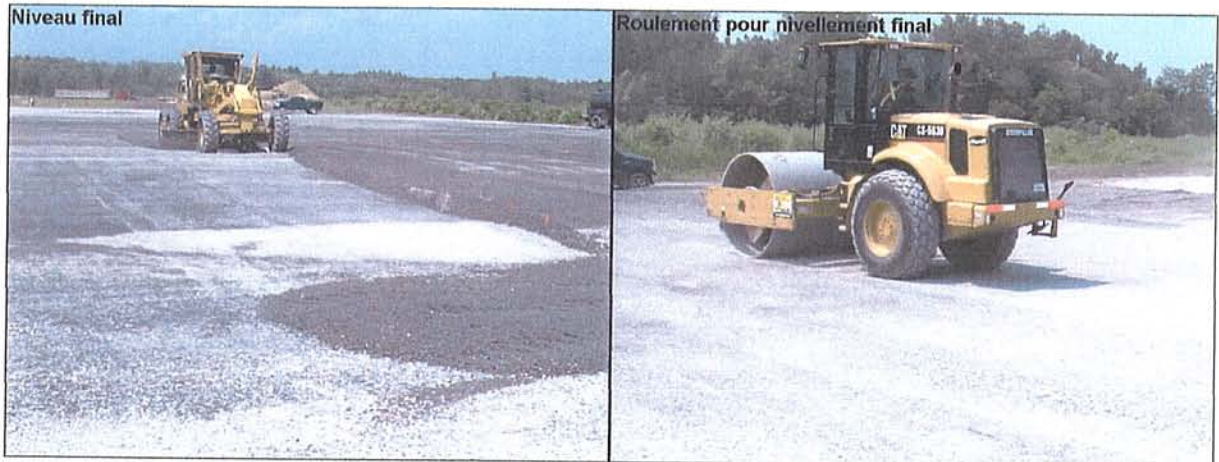
Nivellement final de la fondation supérieure en pierre 0-20 mm (29 juin 2006)
