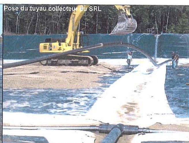
Pose de la tuyauterie SRL – (3 août 2006)
