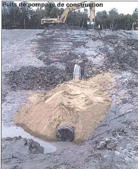
Détail du puits de pompage de construction côté nord –(26 juin 2006)
