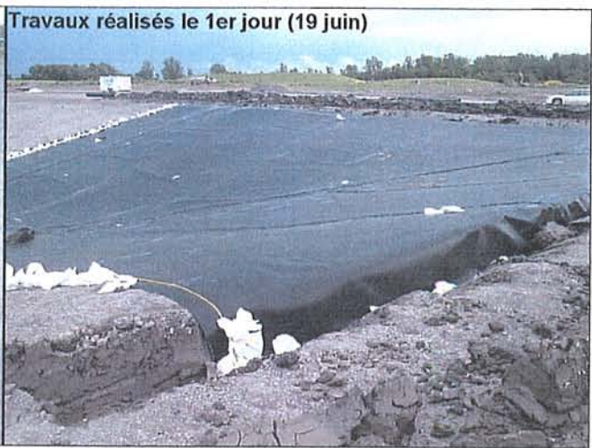
Début d'installation des géomembranes - ( 19 juin 2006)
