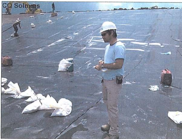
Représentant firme Solmers CQ -Pose Géosynthétiques
