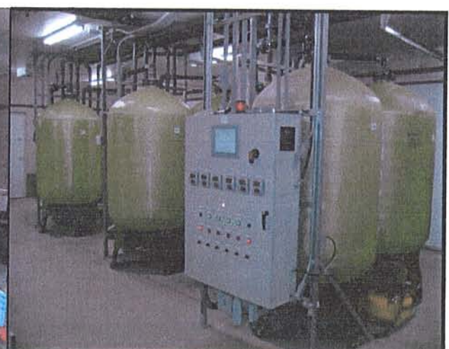
Installation complétée (novembre 06)
