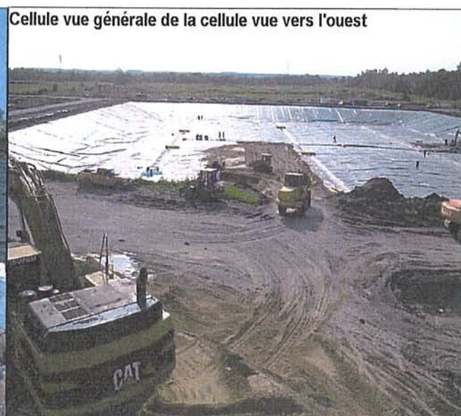
Début d'installation de la 1 ère couche de sable sur géomembrane inférieure – (3 juillet 2006)
