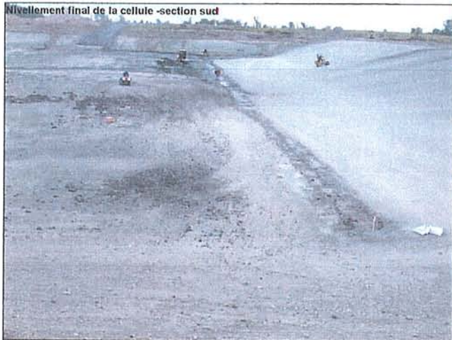
Nivellement final de la cellule- (8 juin 2006)
