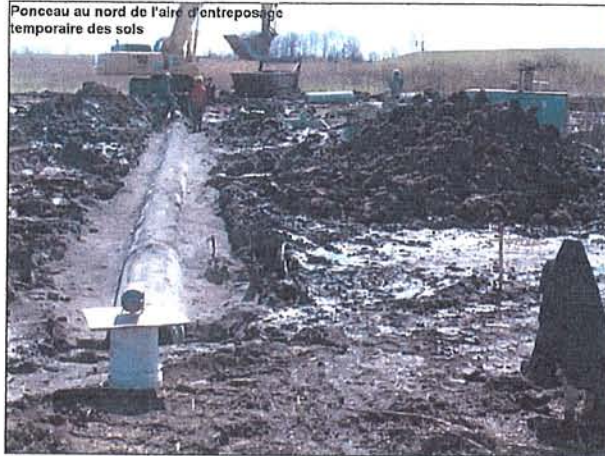
Installation du ponceau au nord de l'AES (27 avril 2006)
