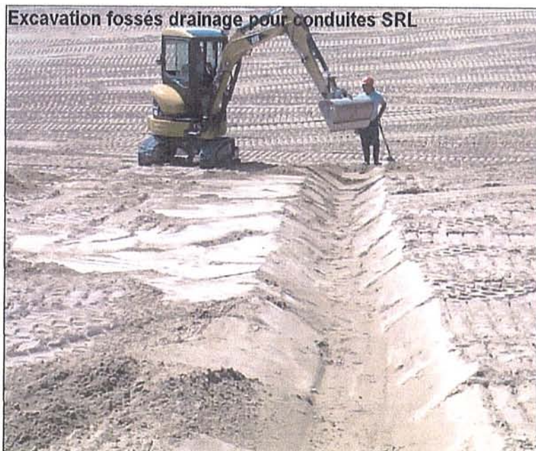
Excavation des tranchées SRL – (13 juillet 2006)
