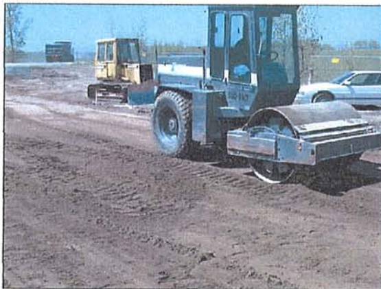
Compaction de la couche de sable existante route de service no.1- entrée du site (25 mai 2005)
