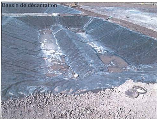
Bassin de décantation complété (10 août 2006)
