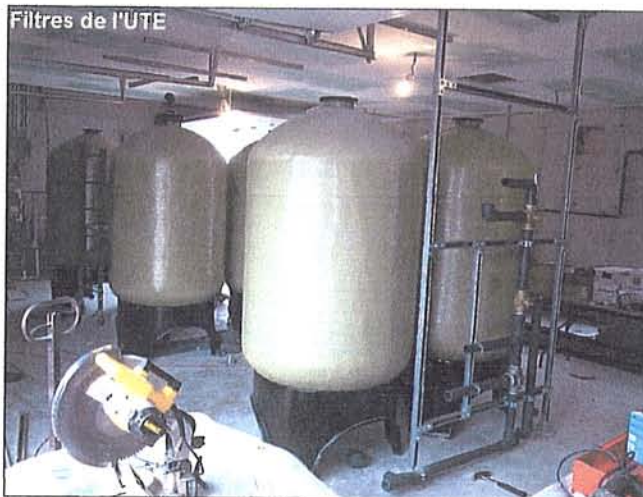
Début installation des équipements (10 septembre 06)
