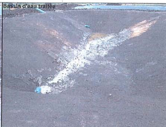
Bassin d'eau traitée avant la pose des géosynthétiques (26 juillet 2006)
