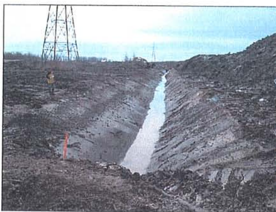
Fossé reprofilé longeant la servitude d'Hydro-Québec (12 avril 2005)
