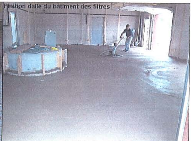
Finition de la dalle de plancher (23 août 06)
