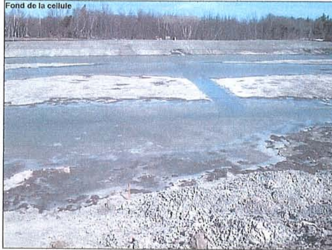
Fond de la cellule – vue vers le nord (21 mars 2006)
