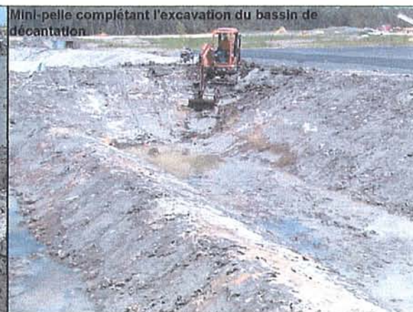
Excavation du bassin de décantation (13 juillet 2006)
