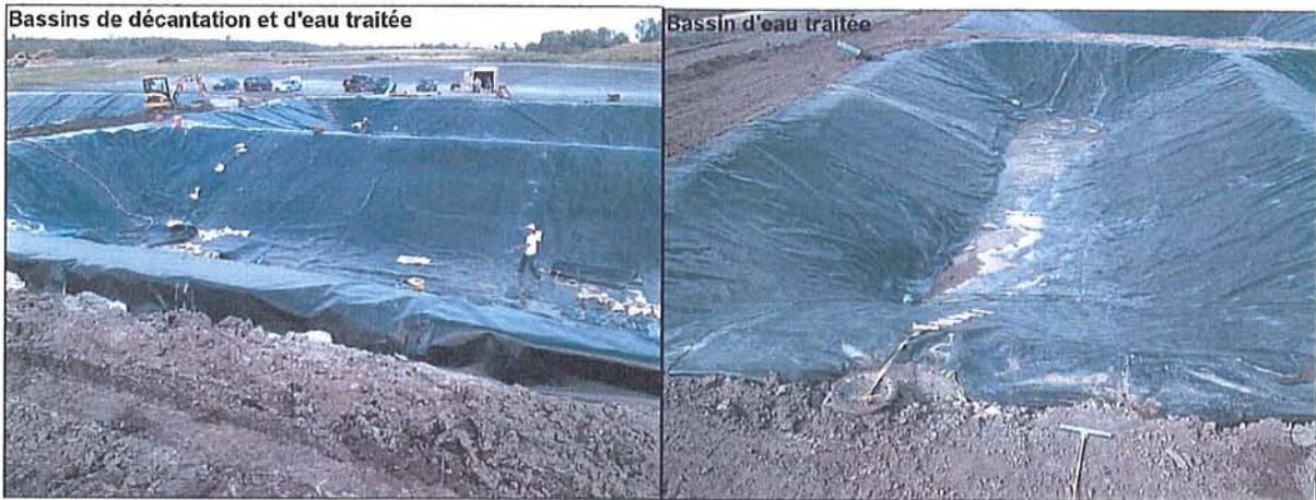
Pose de la géomembrane dans les bassins d'eau traitée et de décantation (4 août 2006)
