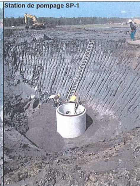
Installation de la station de pompage SP-1 (3 juillet 2006)
