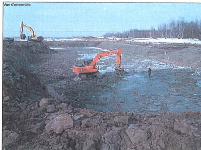
Excavation de la cellule – vue vers le nord-ouest (13 fév 2006)
