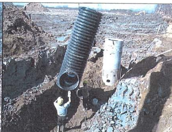
Pose des regards RE-4 (émissaire) et REP-1 (pluvial) (12 avril 2005)
