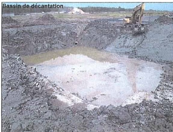
Bassin de sédimentation (4 juillet 2006)
