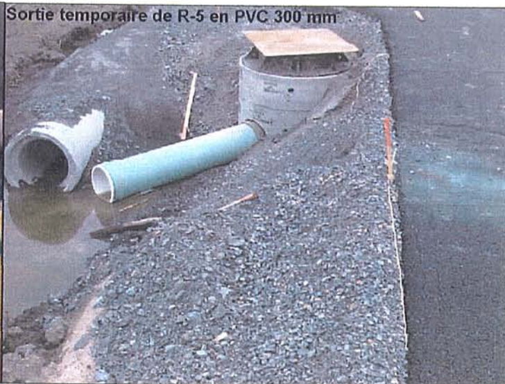
Détail de la sortie temporaire au regard R-5 au nord de l'AES (12 juillet 2006)
