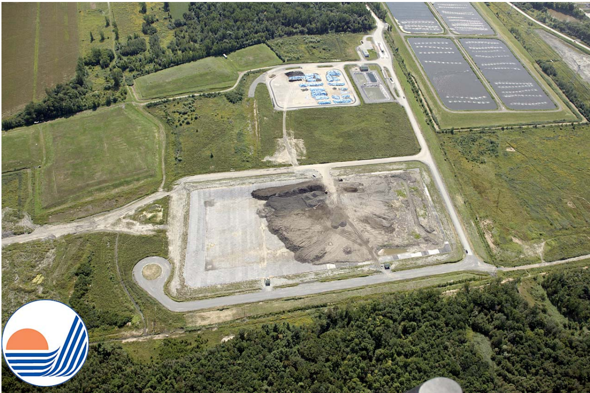
FIGURE 1.3 : INSTALLATION D'ENFOUISSEMENT DES SOLS CONTAMINÉS D'ÉCOLOSOL
