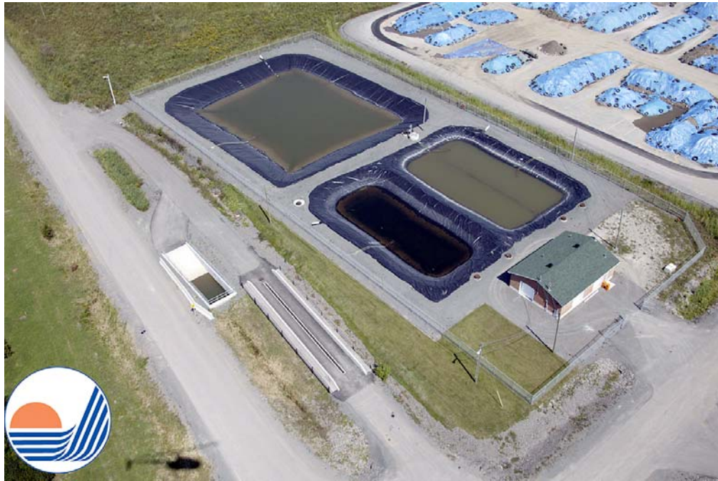
FIGURE 6.1 : INSTALLATION DE TRAITEMENT DES EAUX DE LIXIVIATION D'ÉCOLOSOL
