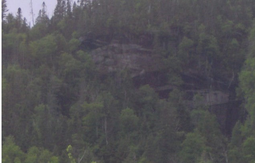
Photo # 5 Falaise du chemin de la vallée de la rivière Brûlé.
