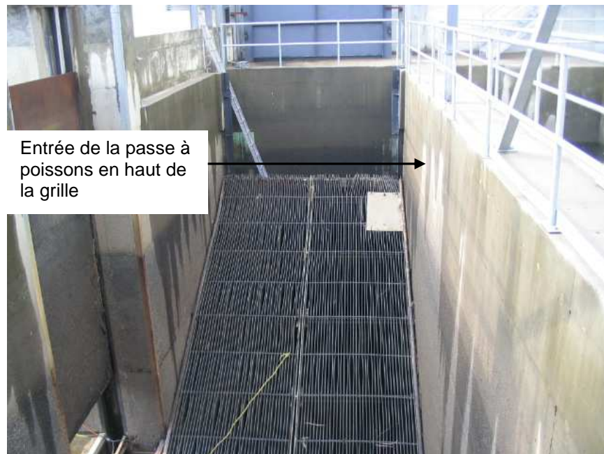
Photo 3 : Grille fine installée à Sainte-Anne (pendant la mise hors d'eau)
