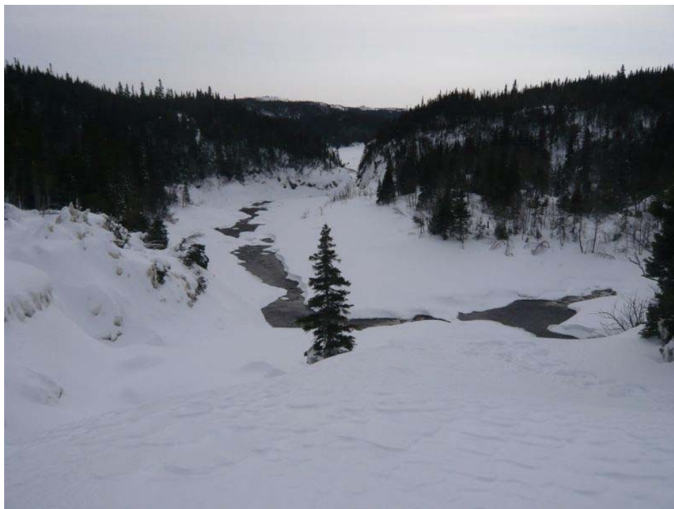
Bief intermédiaire, vue vers l'aval
